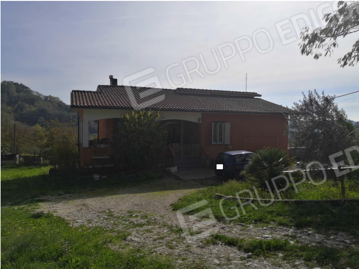
PROSPETTO PRINCIPALE E STARADA DI ACCESSO ALL'EDIFICIO
