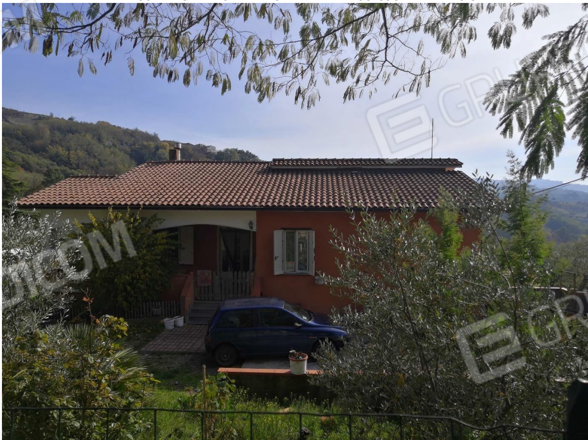
PROSPETTO PRINCIPALE EDIFICIO
