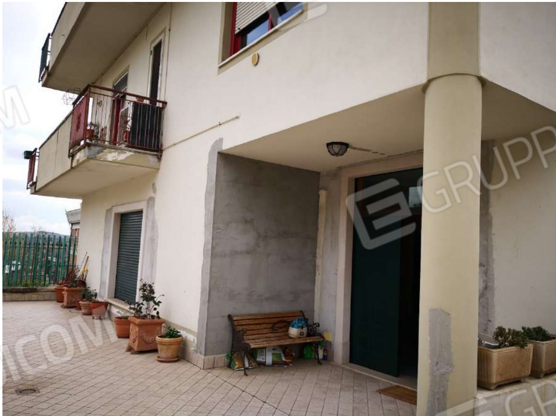
Fotogramma 04 – Vista esterna della fabbricato multipiano – In Catasto F. 29 p.la 482 – Particolare ingresso unità immobiliare commerciale
