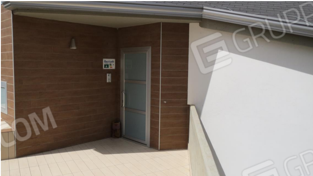
4 Fabbricato Via San Giacomo ingresso secondario
