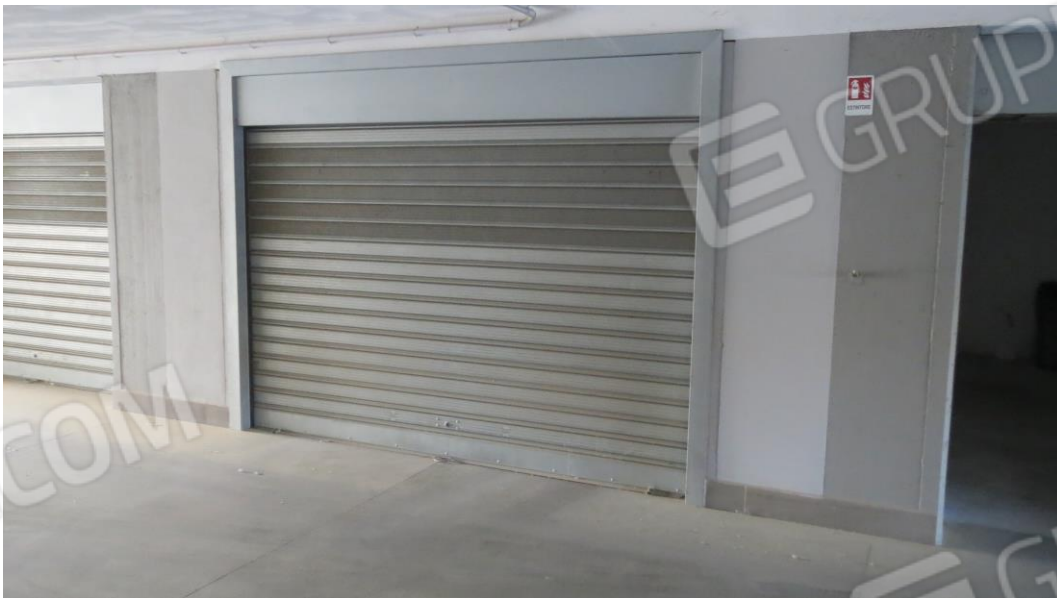
15 Fabbricato Via Pagliarelle vista corsia piano terra box sub 10
