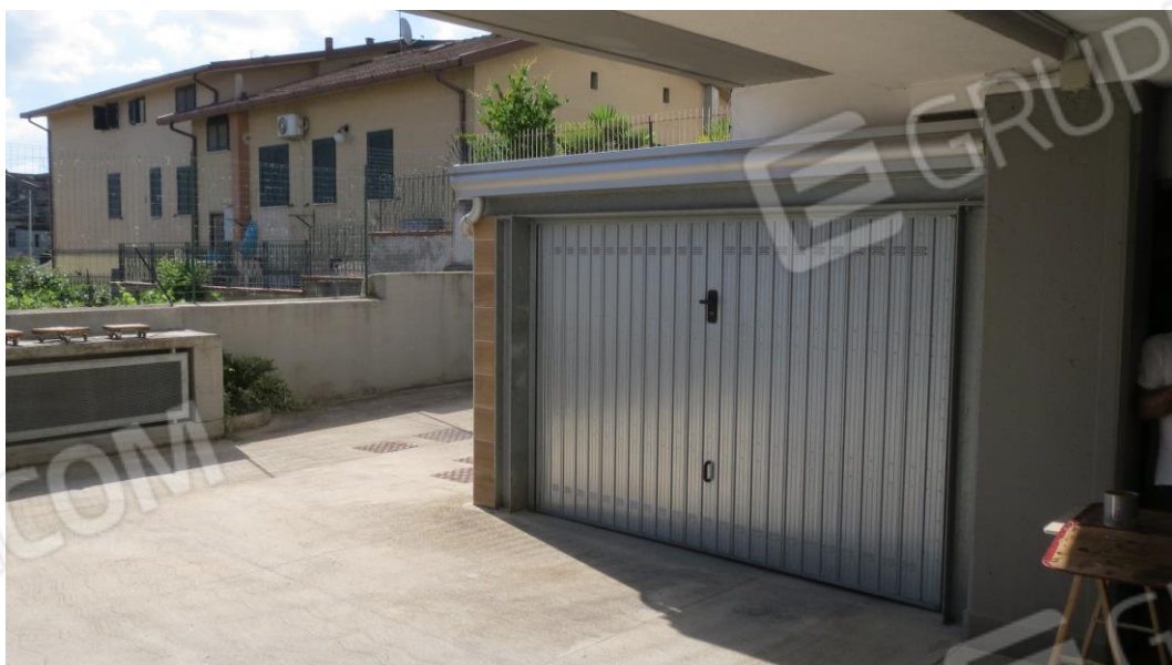
17 Fabbricato Via Pagliarelle vista piano terra box sub 17
