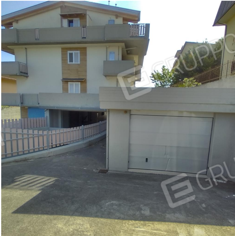
7 Fabbricato Via Pagliarelle vista box sub 14
