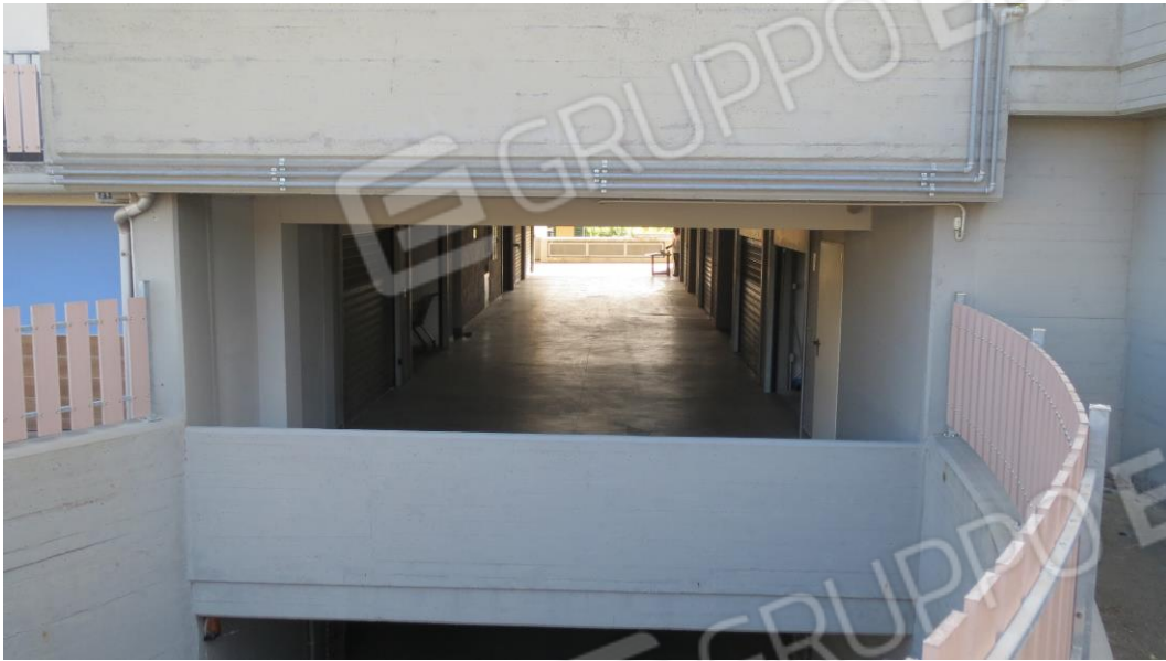
14 Fabbricato Via Pagliarelle vista corsia box piano terra
