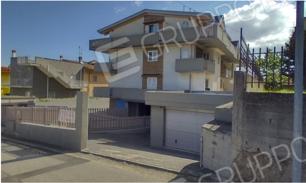
1 Fabbricato Via Pagliarelle snc / Traversa I Viale Spinelli, 12
