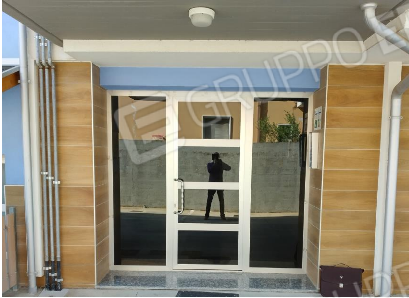
18 Fabbricato Via Pagliarelle
