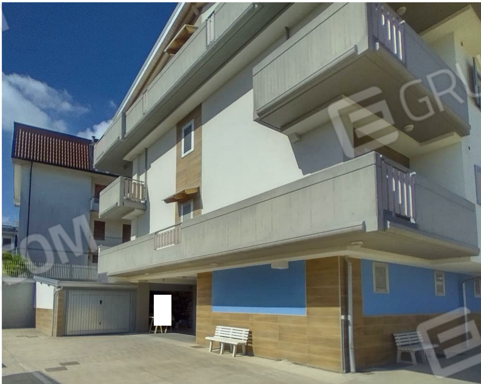
4 Fabbricato Via Pagliarelle vista box sub 17
