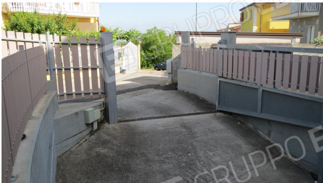
10 Fabbricato Via Pagliarelle vista cancello rampa autorimessa
