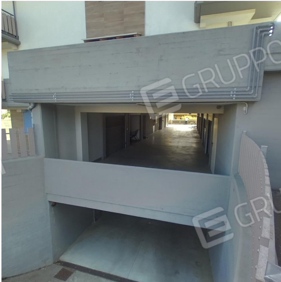
9 Fabbricato Via Pagliarelle vista box piano terra e rampa autorimessa
