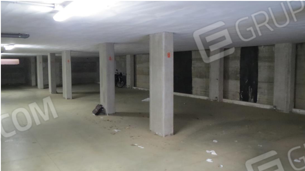
13 Fabbricato Via Pagliarelle vista autorimessa piano sottostrada
