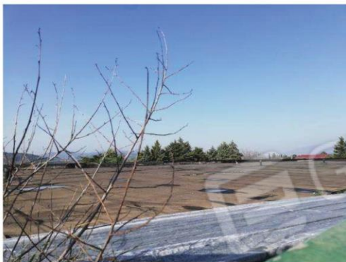
foto 41: ... stato della copertura
