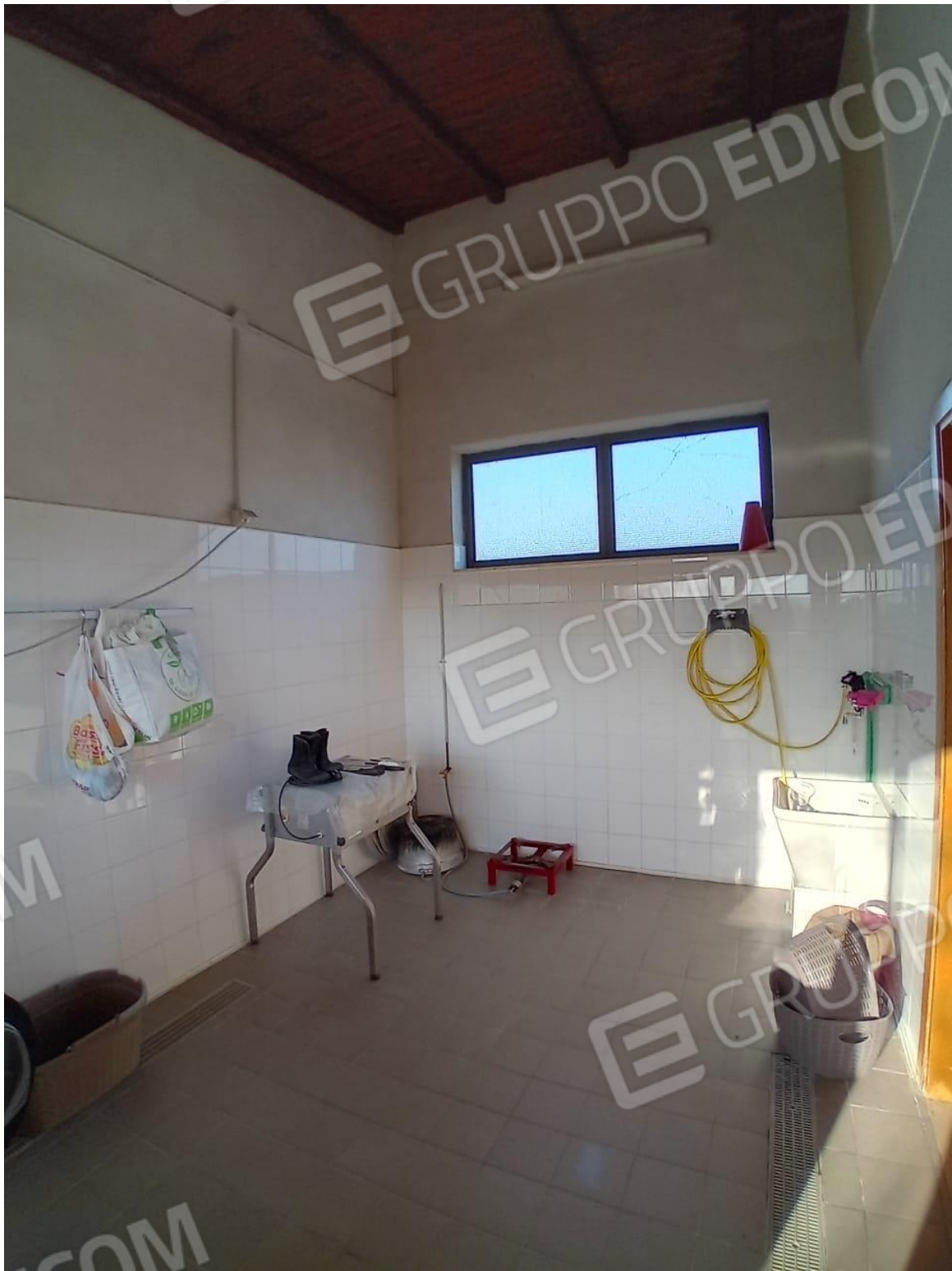
Foto n. 8__ Locale macelletto (Foglio 17 p.lla 2176 sub 3)
