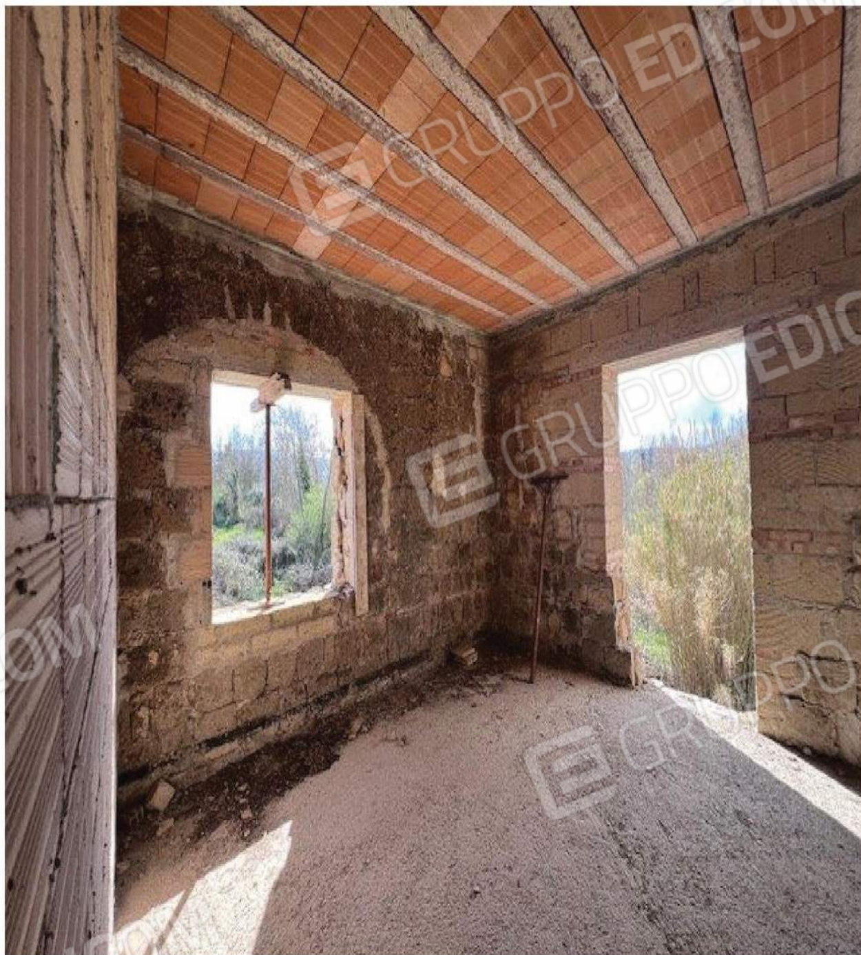
VISTA INTERNO LOTTO N. 1 CORPO H
