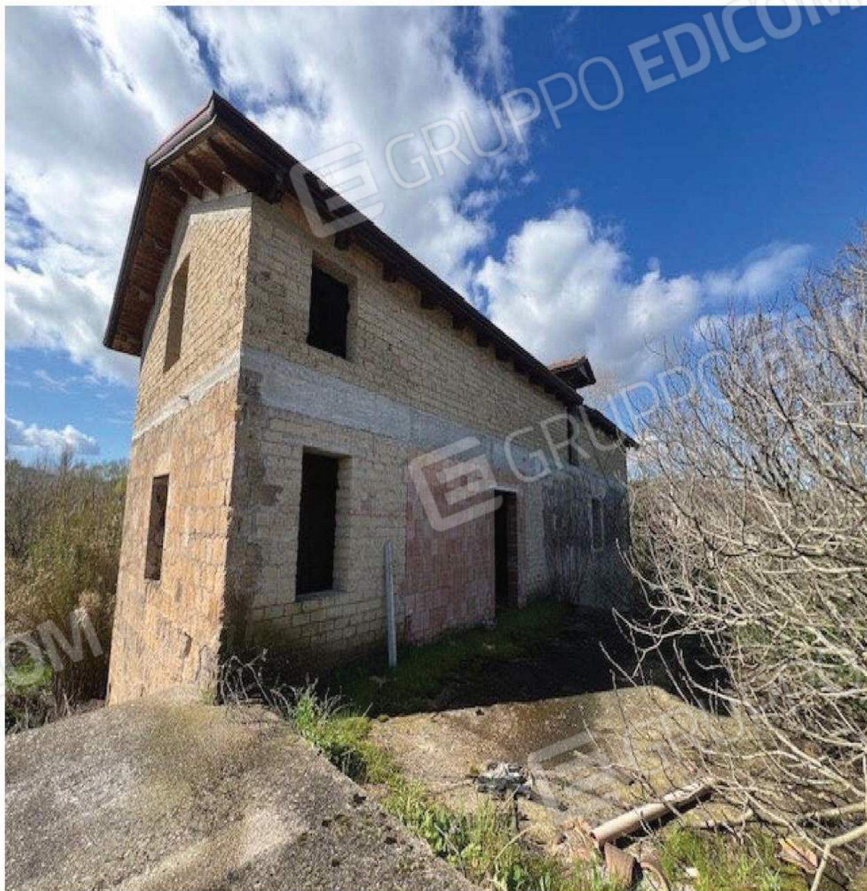
VISTA ESTERNO LOTTO N. 1 CORPO H e I DAL LATO EST
