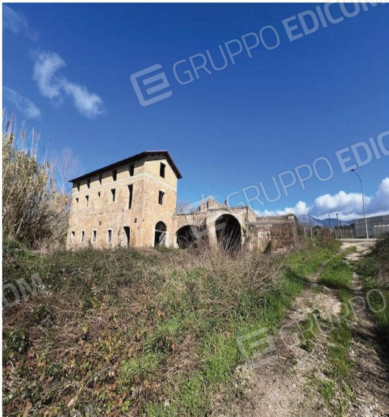
VISTA DAL LATO OVEST LOTTO N. 1 CORPO H, I, K
