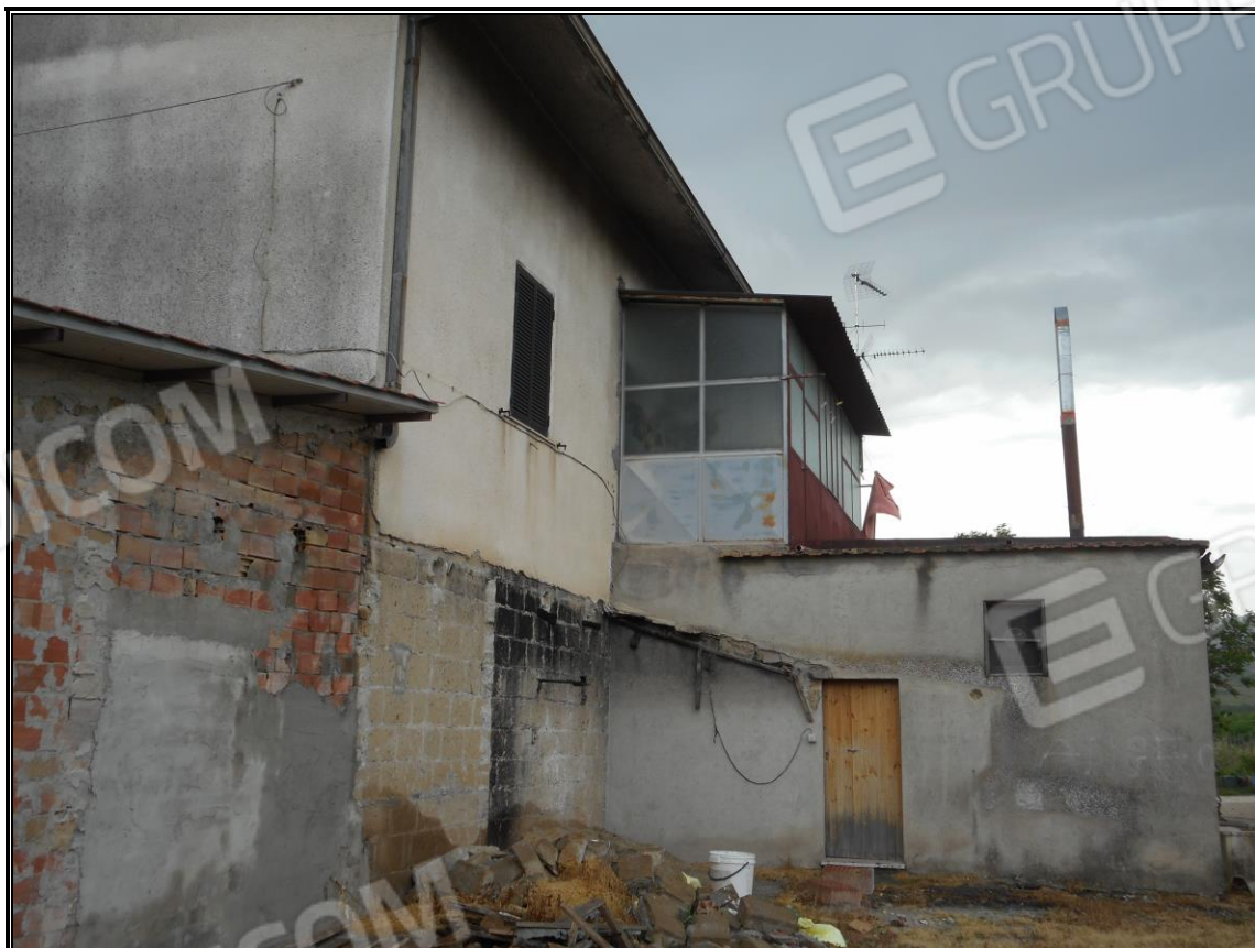
FOTO 4 – Particella 1035 sub 3 e sub 2 (Abitazione - Depositi) : il prospetto laterale sx sul quale erano ubicati i locali deposito demoliti
