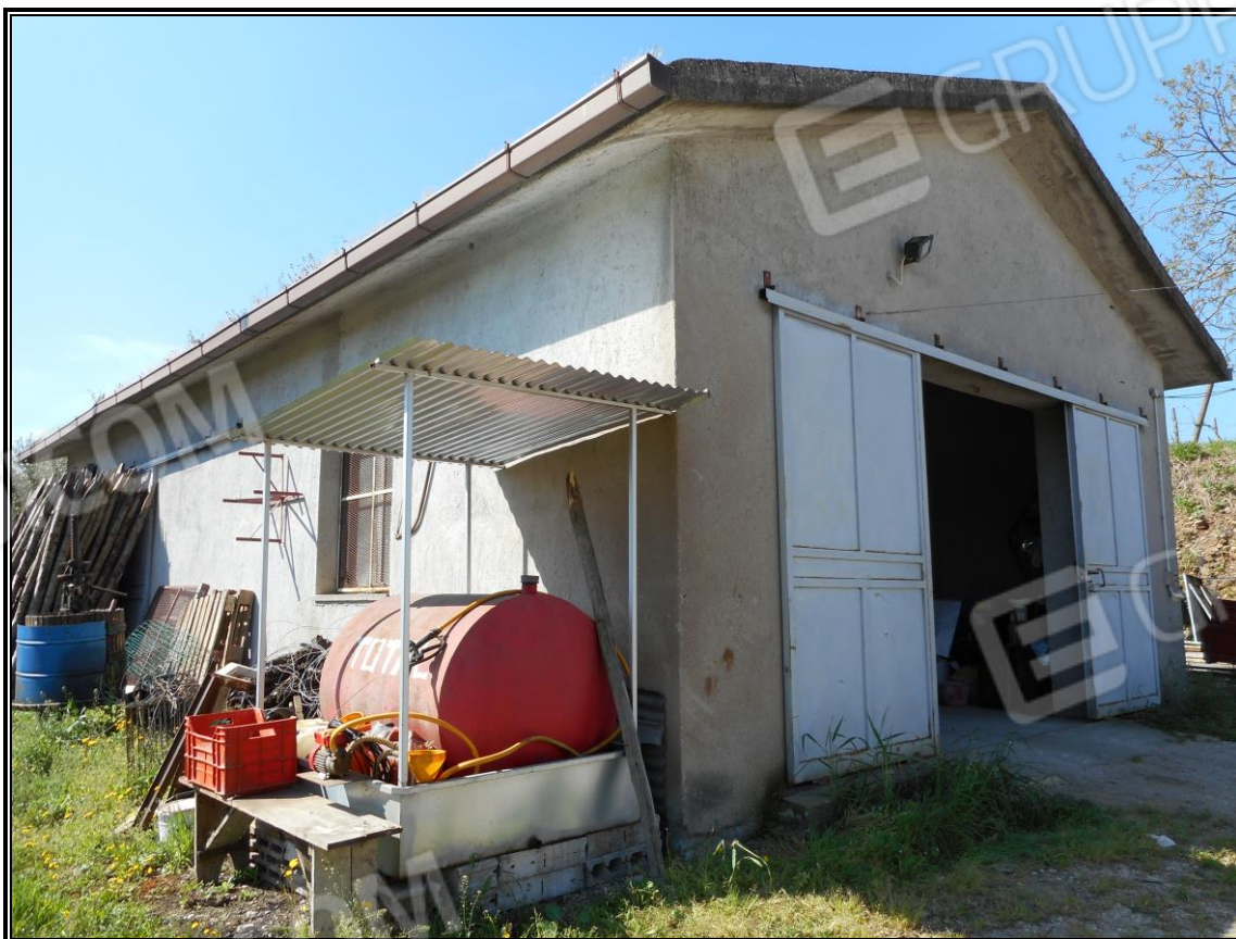
FOTO 2 – Particella 957 sub 2 (Deposito) : i prospetti principale e laterale sx
