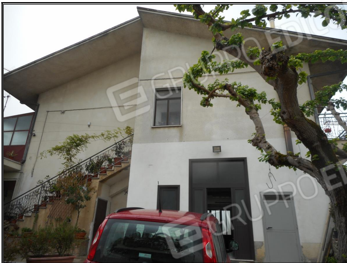
FOTO 1 – Particella 1035 sub 3 e sub 2 (Abitazione - Depositi): il prospetto principale del corpo su due livelli.
