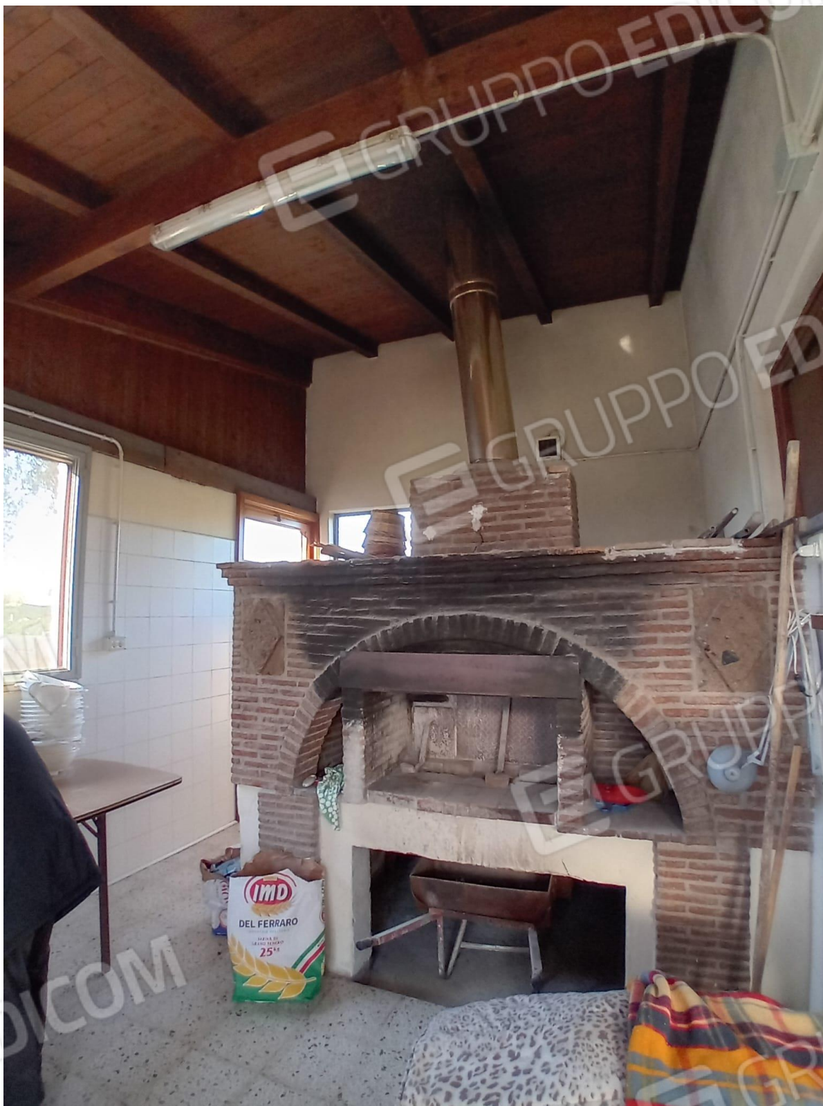
Foto n. 5__ Locale panificazione (Foglio 17 p.lla 2176 sub 1)
