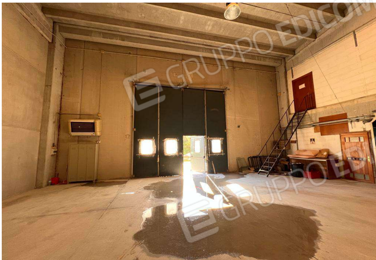
DEPOSITO CON SCALA ACCESSO PIANO SUPERIORE
