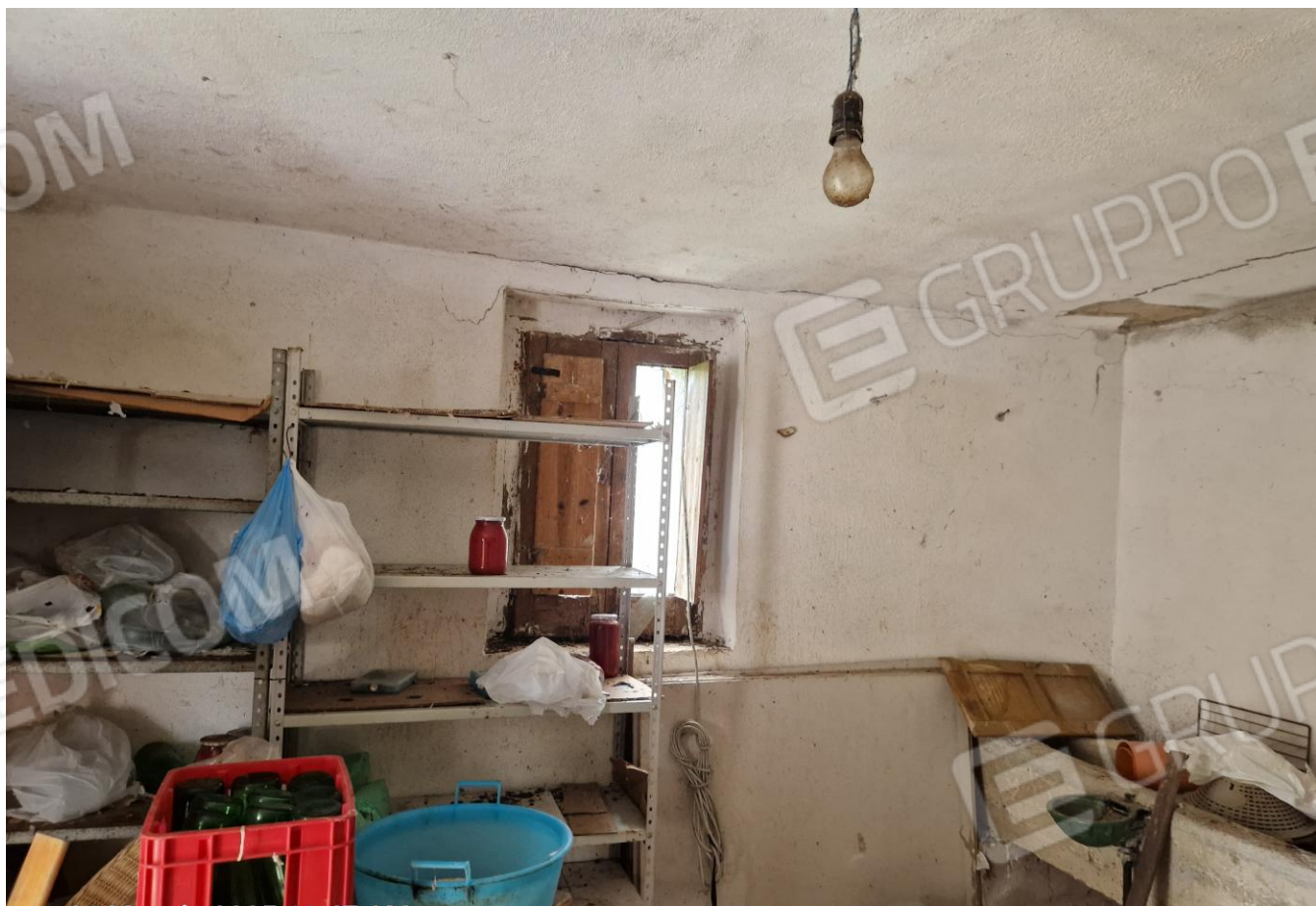
Foto n. 4: Deposito (piano seminterrato)
