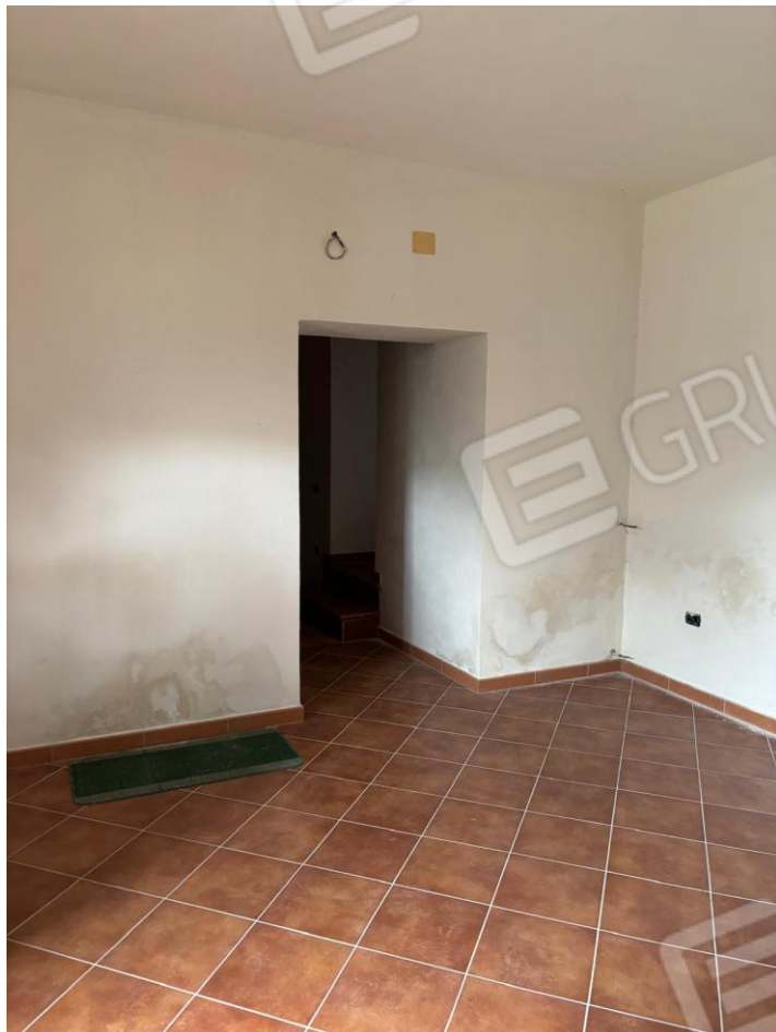
Foto n. 3: Fabbricato adibito a civile abitazione – Cantina 1
