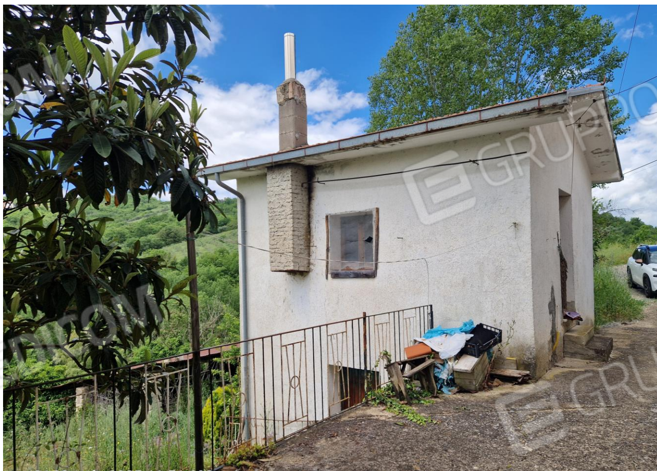
Foto n. 2: Prospetto laterale del Deposito
