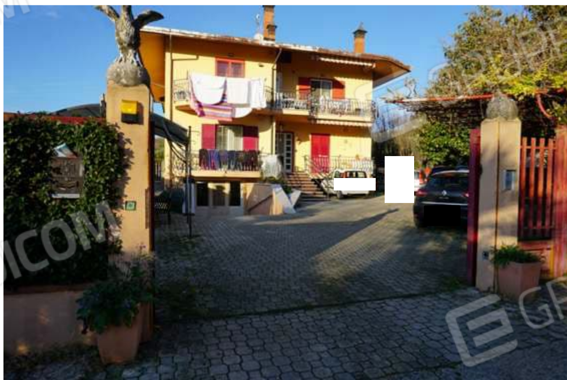
Fig.2 – Vista su fronte principale
