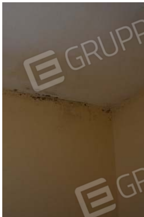
Fig.14-15 – Vista dei fenomeni di condensa
