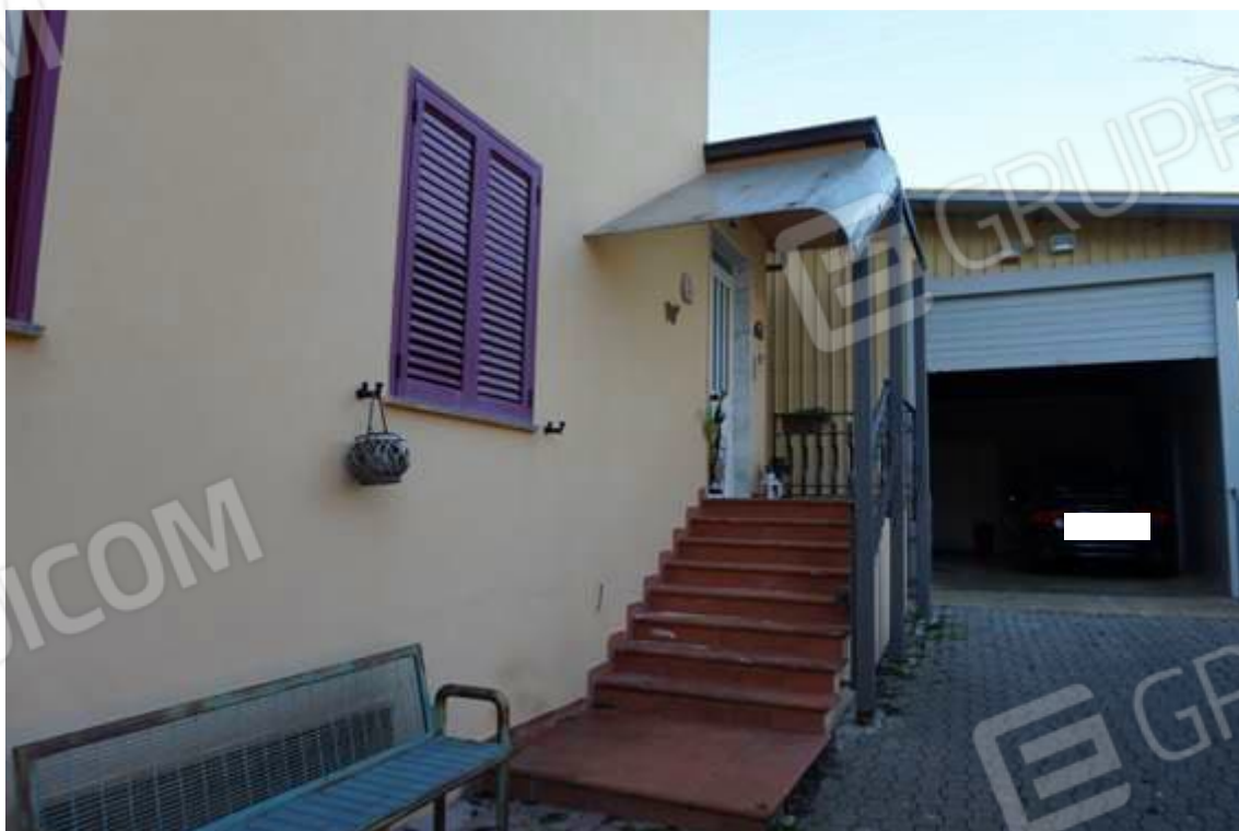
Fig.4 – Vista su vano scala/profferlo
