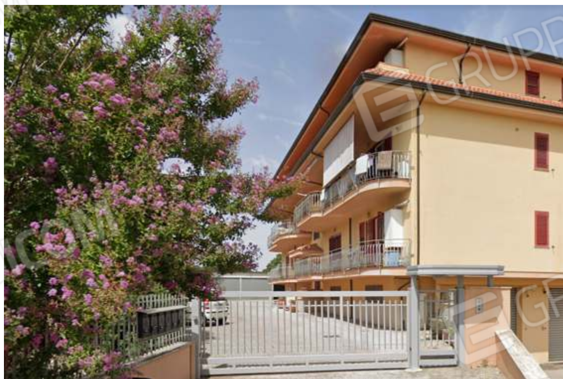
Fig.2 – Vista da cancello d’ingresso del lotto da via Ciesco Porrelle (fonte Google Maps 2021)
