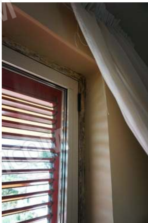
Fig.14-15 – Vista dei fenomeni di condensa
