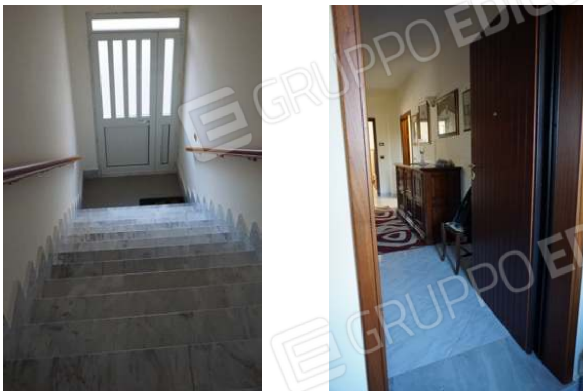
Fig.5-6 – Vista del vano scala coperto e accesso all'appartamento
