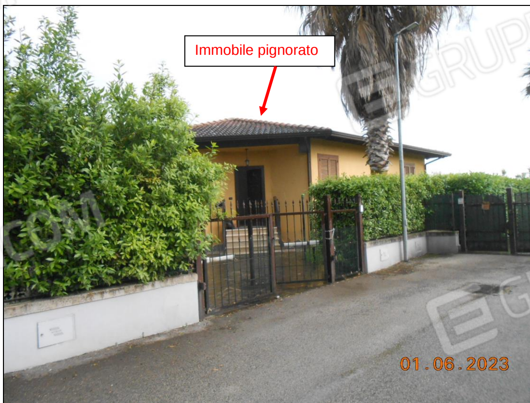
FOTO N. 02 Vista dell'immobile pignorato. Si nota l'accesso carrabile e pedonale.
