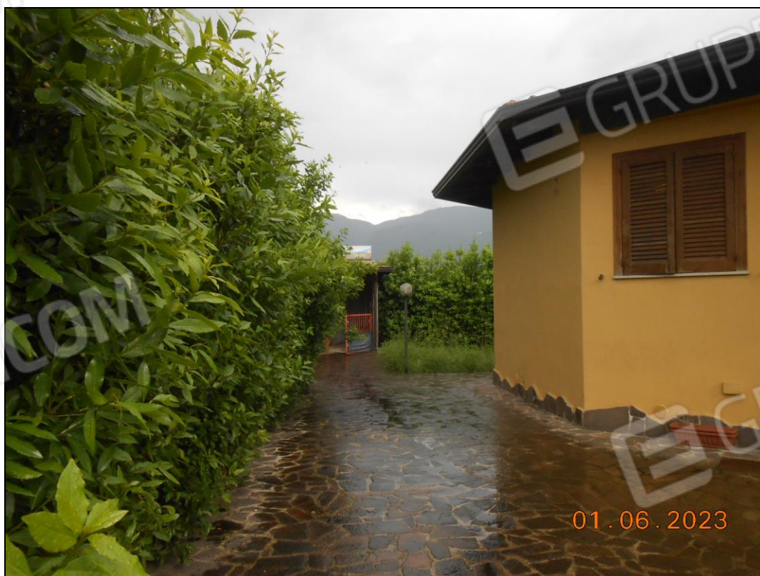
FOTO N. 06 Vista dell'area pertinenziale adibita a giardino e a vialetti di transito. Si nota la siepe disposta lungo il confine del lotto.
