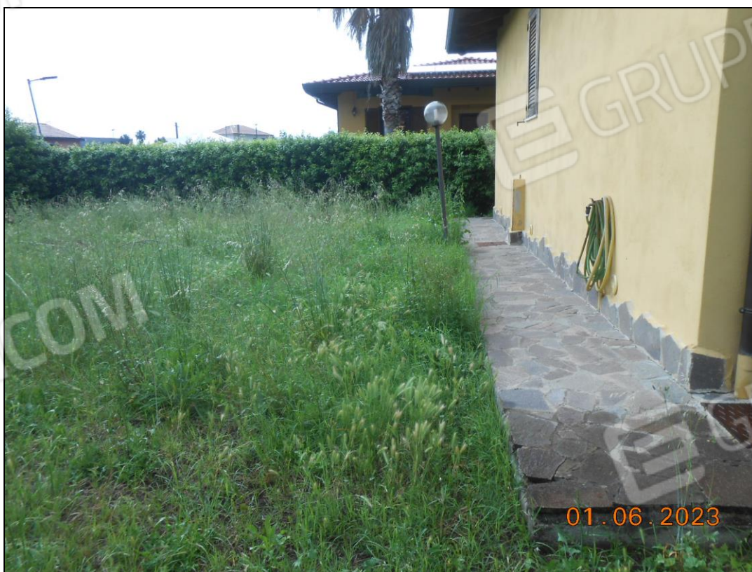
FOTO N. 14 Vista dell'immobile. Si nota il camminamento intorno al fabbricato, pavimentato con lastre in porfido irregolari.
