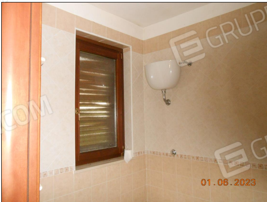
FOTO N. 34 Vista interna dell'immobile.
