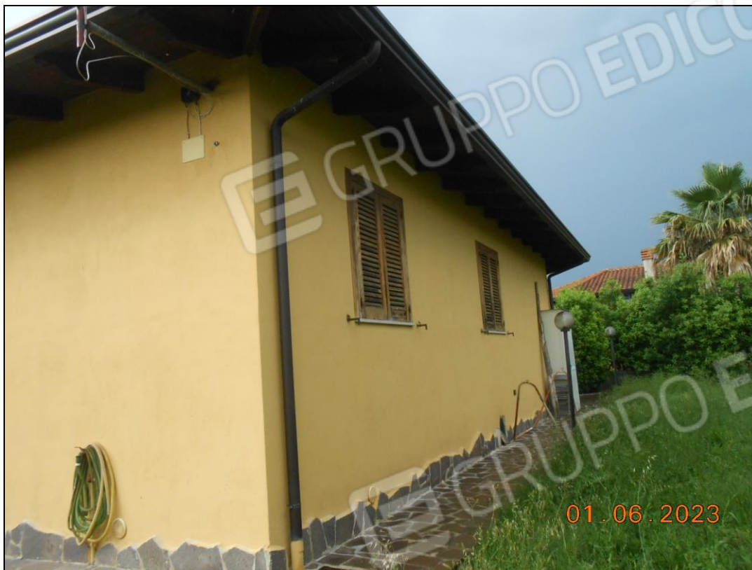
FOTO N. 13 Vista dell'immobile. Si nota l'illuminazione esterna su lampioni.
