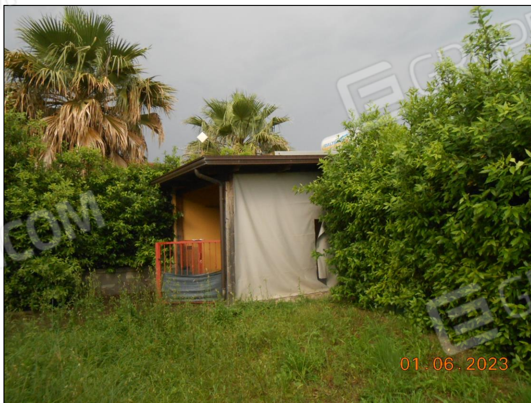
FOTO N. 10 Vista del box – gazebo dell'immobile. Si nota lo stato di abbandono.
