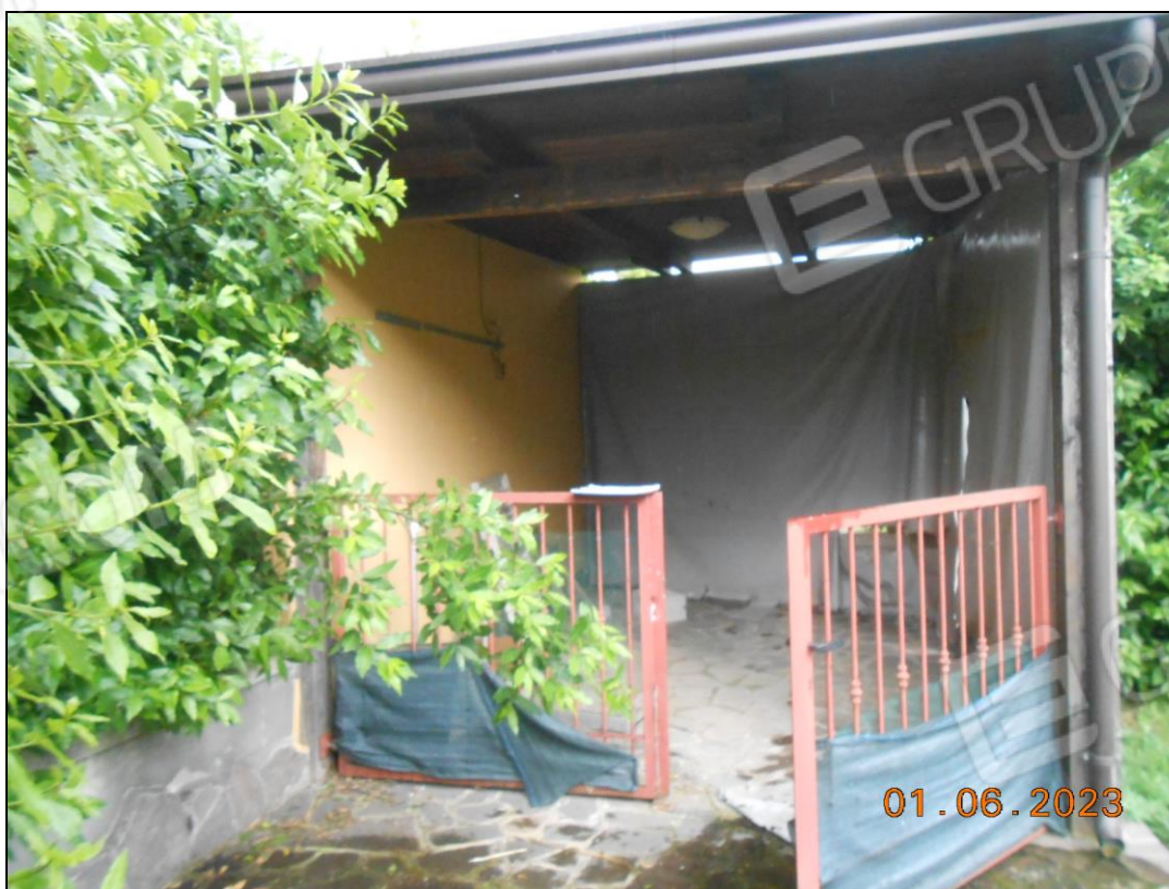
FOTO N. 12 Vista del box dell'immobile.
