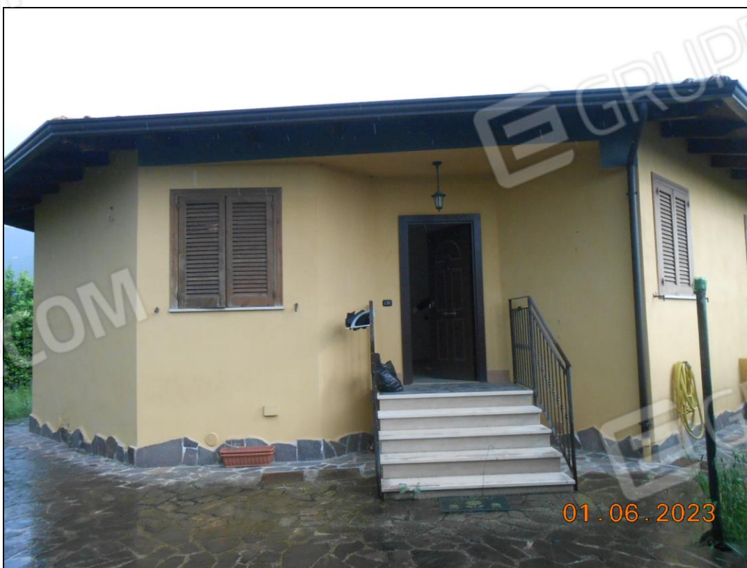
FOTO N. 04 Vista rampa di accesso dell'immobile pignorato.
