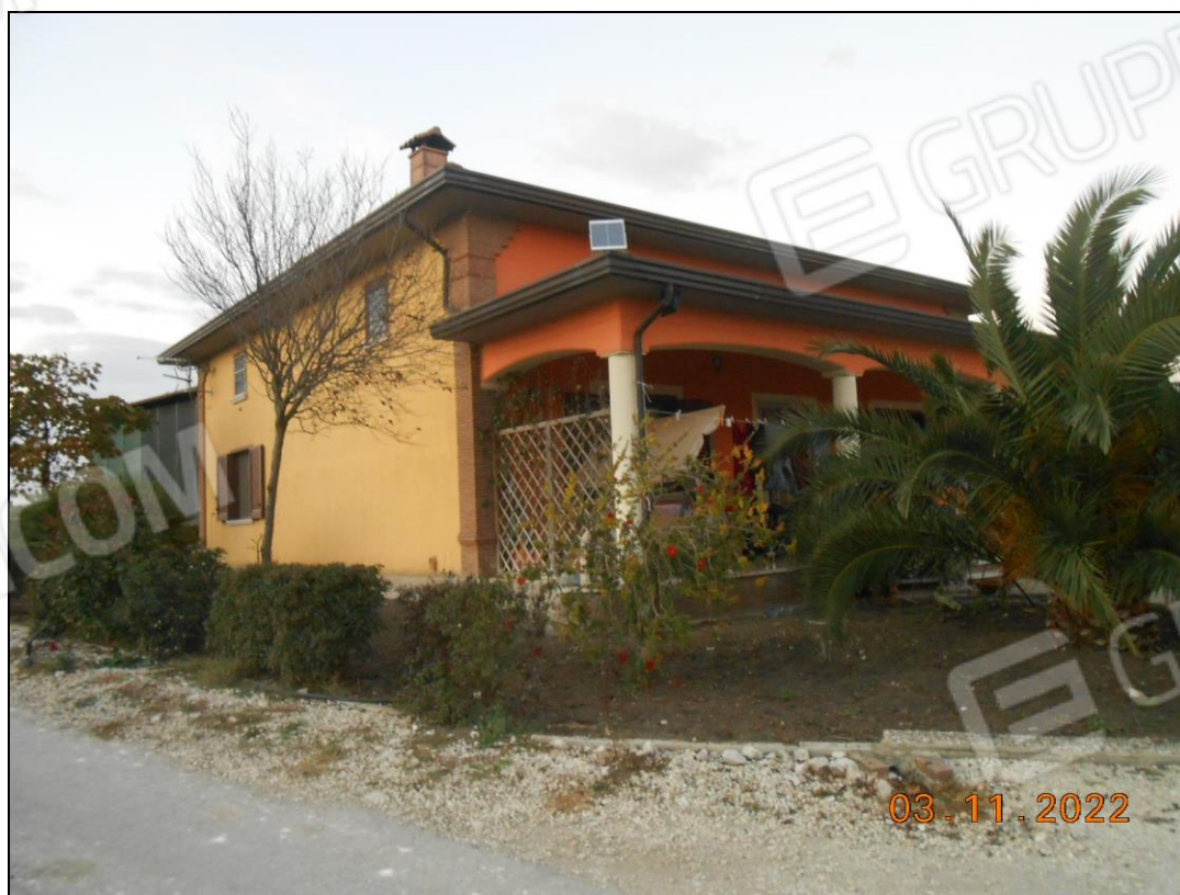
FOTO N. 02 Vista dell'immobile pignorato, p.lle 436/1, 1136, 1137 e 435/7.
