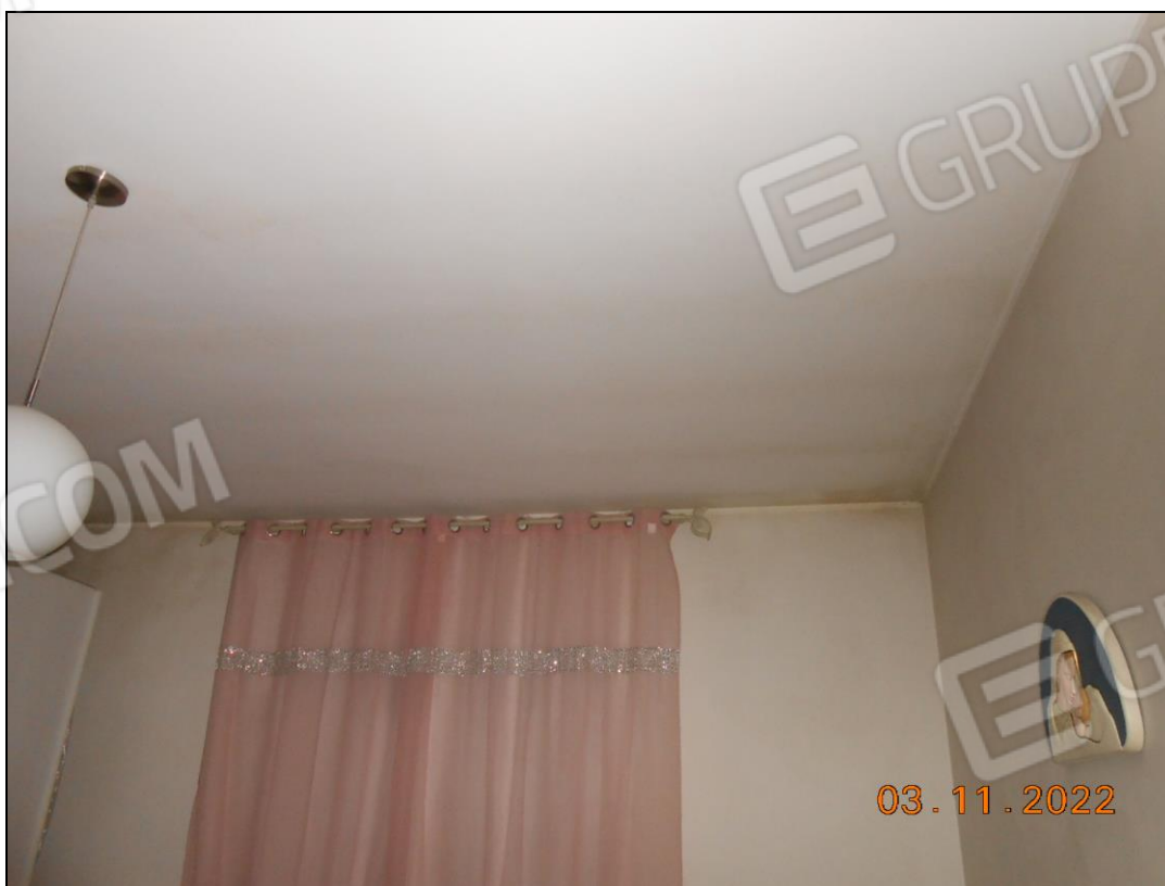
FOTO N. 20 Vista interna a piano terra dell'immobile pignorato. Si notano macchie di condensa sulle pareti e soffitto.
