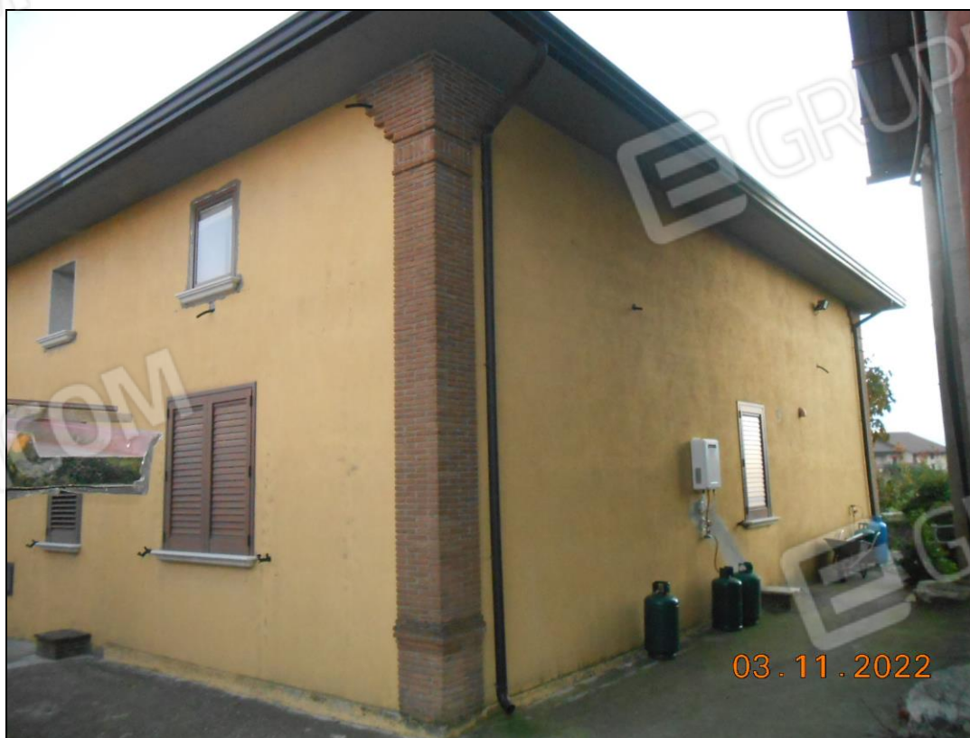
FOTO N. 06 Vista dell'immobile pignorato, p.lle 436/1, 1136, 1137 e 435/7.
