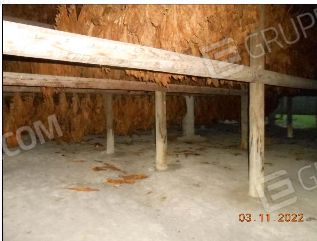
FOTO N. 52 Particolare dei pali cementati alla base. Capanna adibita a stenditoio per il tabacco, fg. 3 p.la 435/8.
