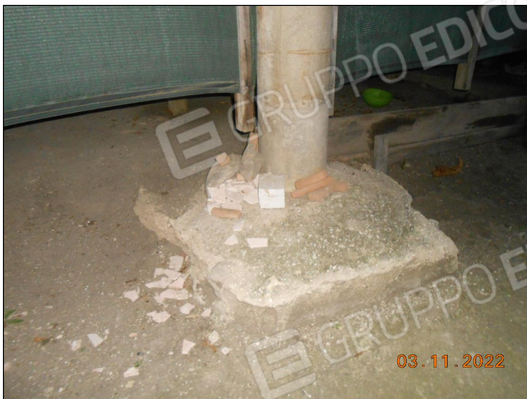
FOTO N. 51 Particolare dei pali di cemento vibro compressi cementati alla base. Capanna adibita a stenditoio per il tabacco, fg. 3 p.la 435/8.
