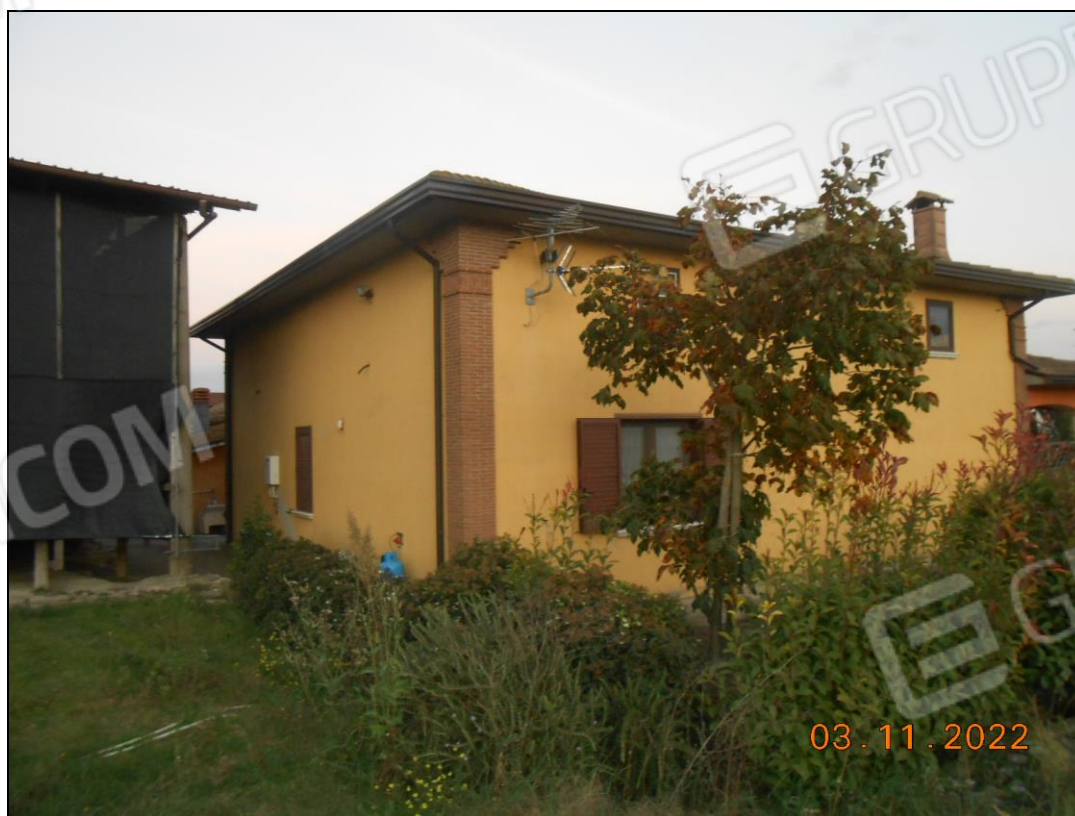
FOTO N. 04 Vista dell'immobile pignorato, p.lle 436/1, 1136, 1137 e 435/7.
