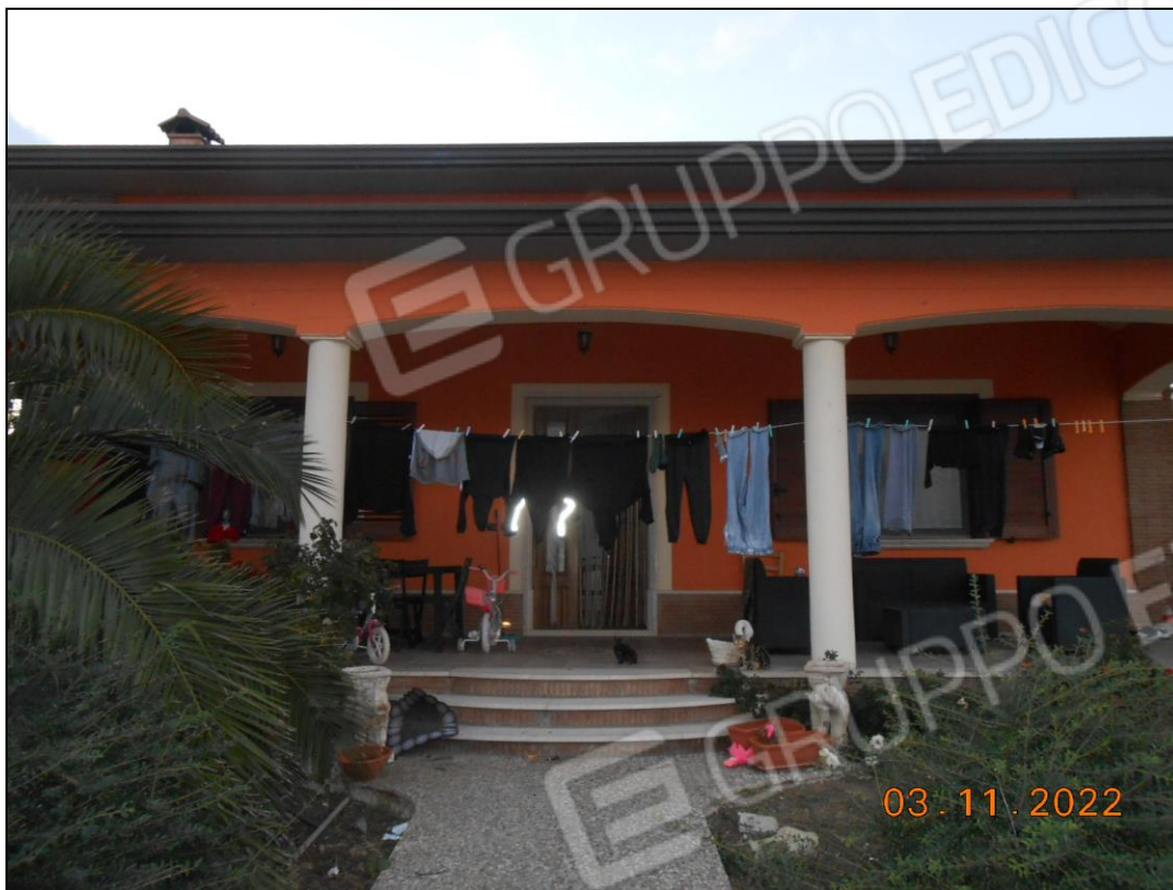
FOTO N. 07 Vista ingresso dell'immobile pignorato.
