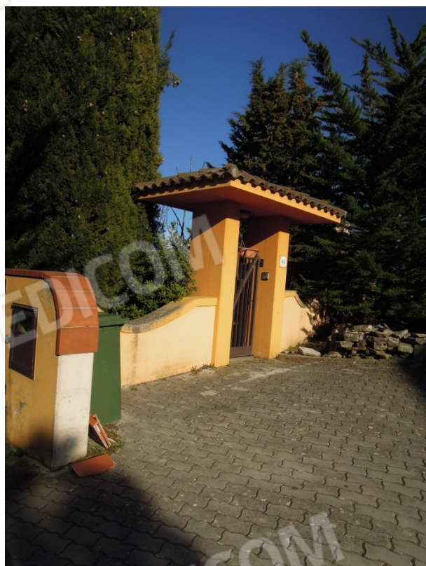
Ingresso pedonale e carrabile
