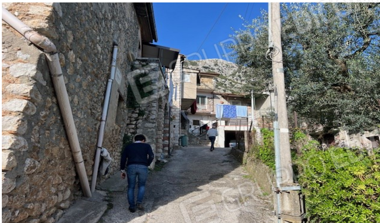
STRADA DI ACCESSO ALLE ABITAZIONE FG. 14 P.LLA 13 SUB 17, 19,21 – LOTTO N. 1 CORPO A e B. VITULANO
