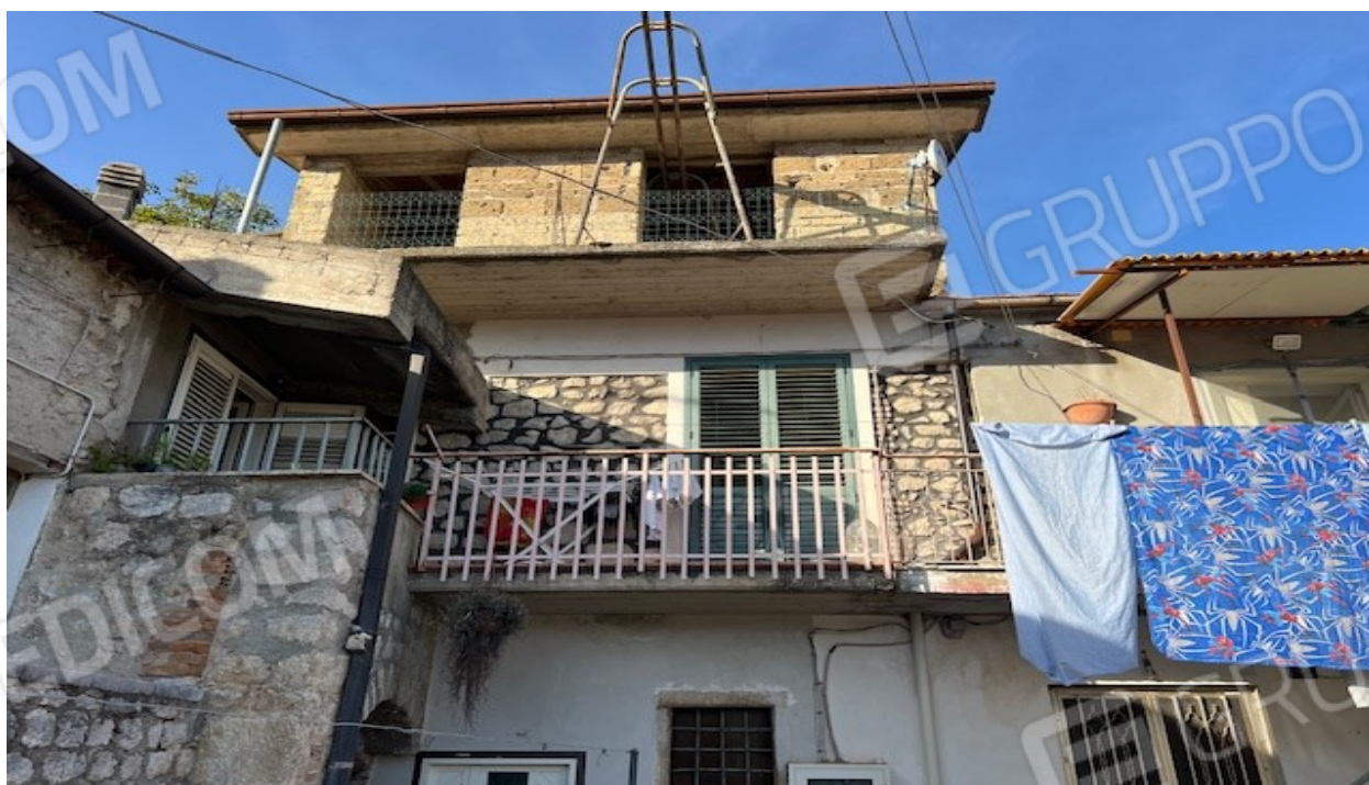
PROSPETTO PRINCIPALE FABBRICATO FG. 14 P.LLA 13 SUB 17,19,21 – LOTTO N. 1 CORPO A e B. VITULANO
