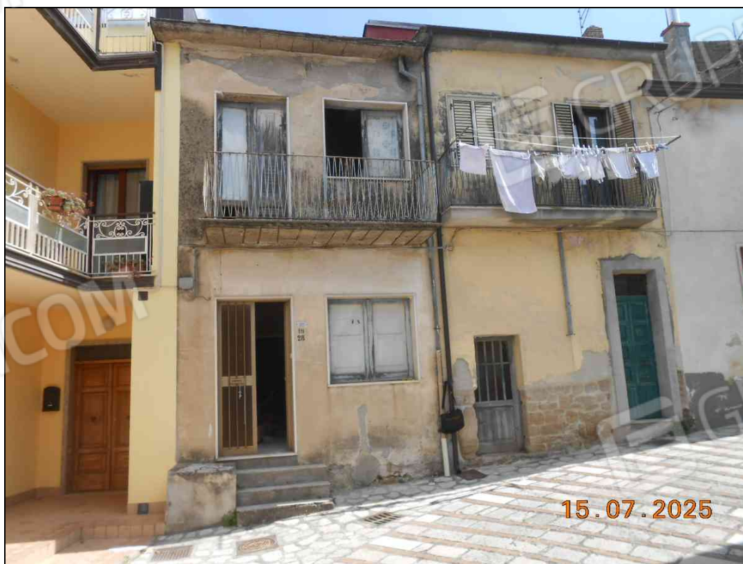
FOTO N. 02 Vista porzione dell'immobile pignorato, su via f.lli Cairoli n. 26-28.
