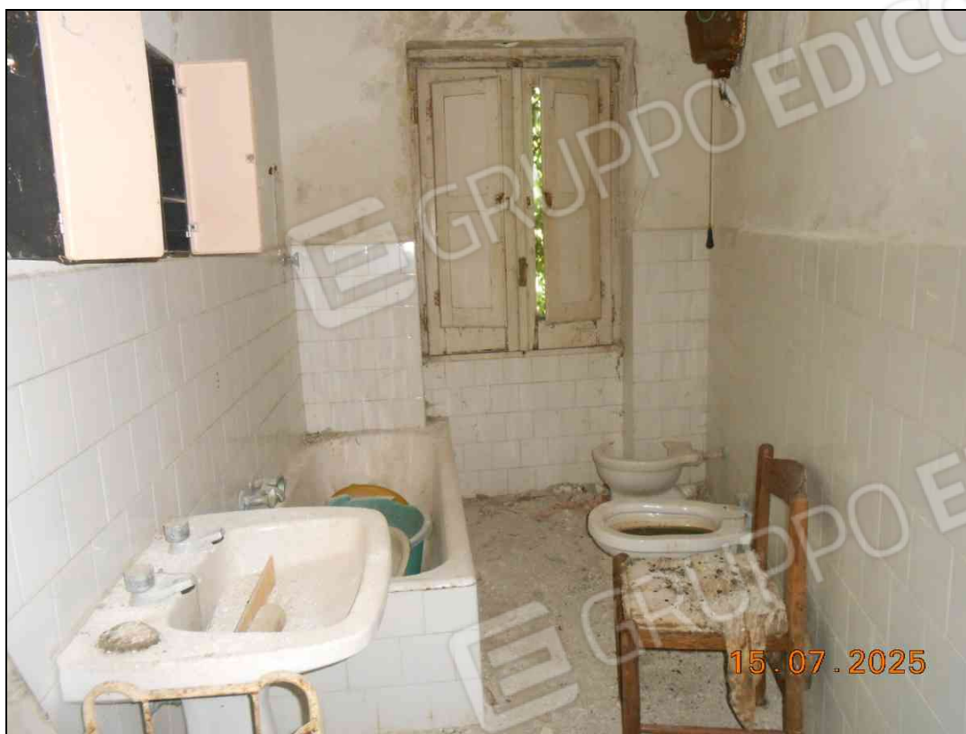
FOTO N. 35 Vista interna del piano primo dell'immobile.
