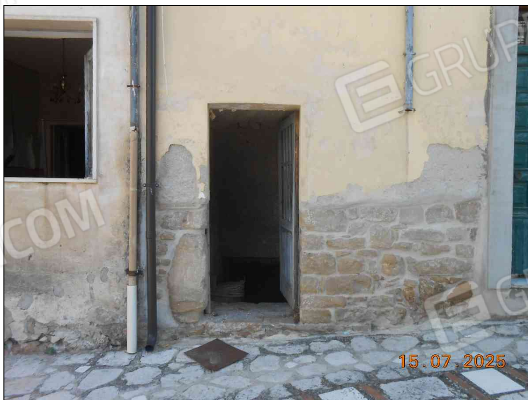
FOTO N. 04 Vista ingresso del locale al piano interrato.
