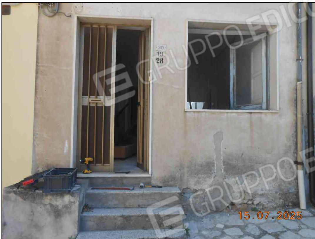
FOTO N. 11 Vista ingresso porzione immobile al piano terra.
