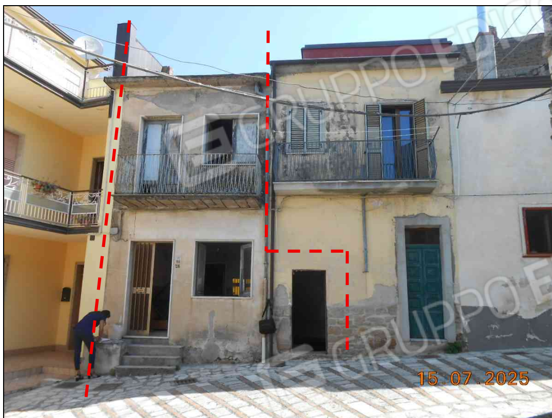
FOTO N. 01 Vista porzione dell'immobile pignorato, su via f.lli Cairoli n. 26-28.
