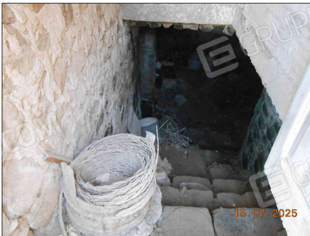
FOTO N. 06 Vista scala di accesso del locale al piano interrato.
