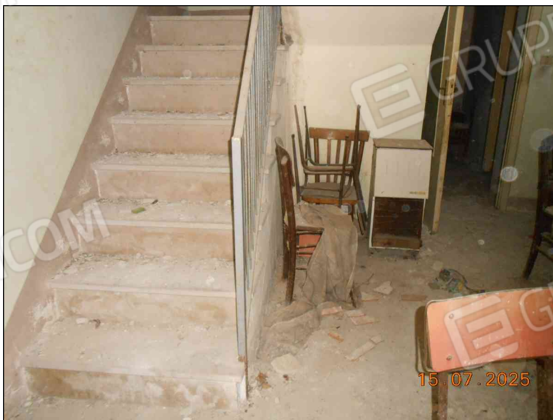
FOTO N. 24 Vista interna piano terra dell'immobile. Si nota la scala di accesso al P.I.
