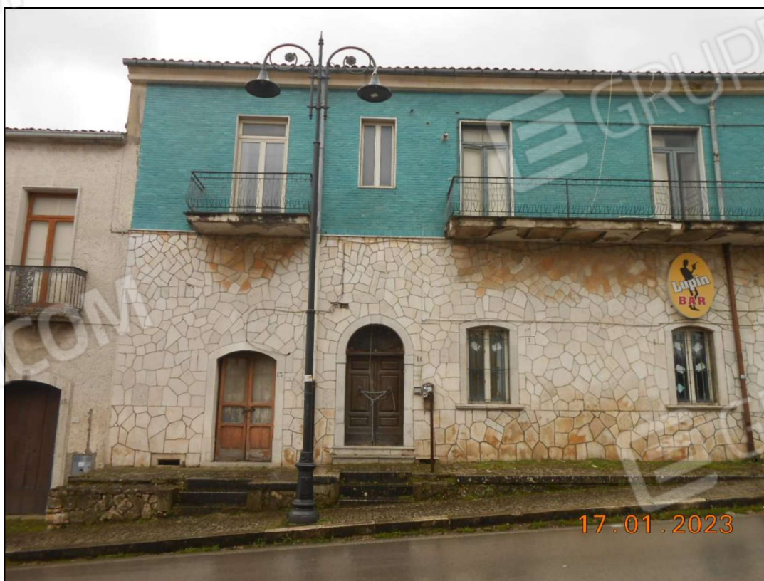
FOTO N. 06 Vista dell'immobile pignorato.
