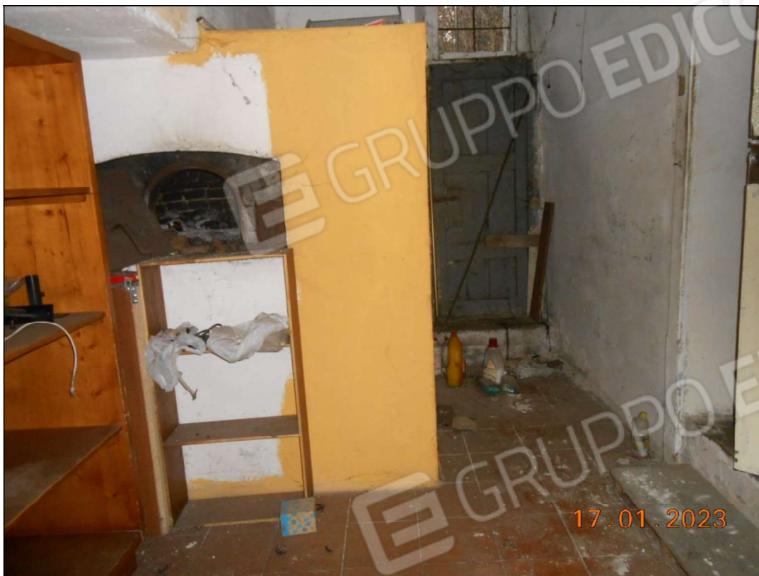
FOTO N. 31 Vista interna del piano terra.
