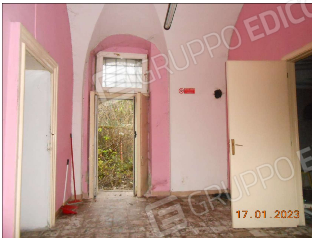
FOTO N. 25 Vista interna del piano terra.
