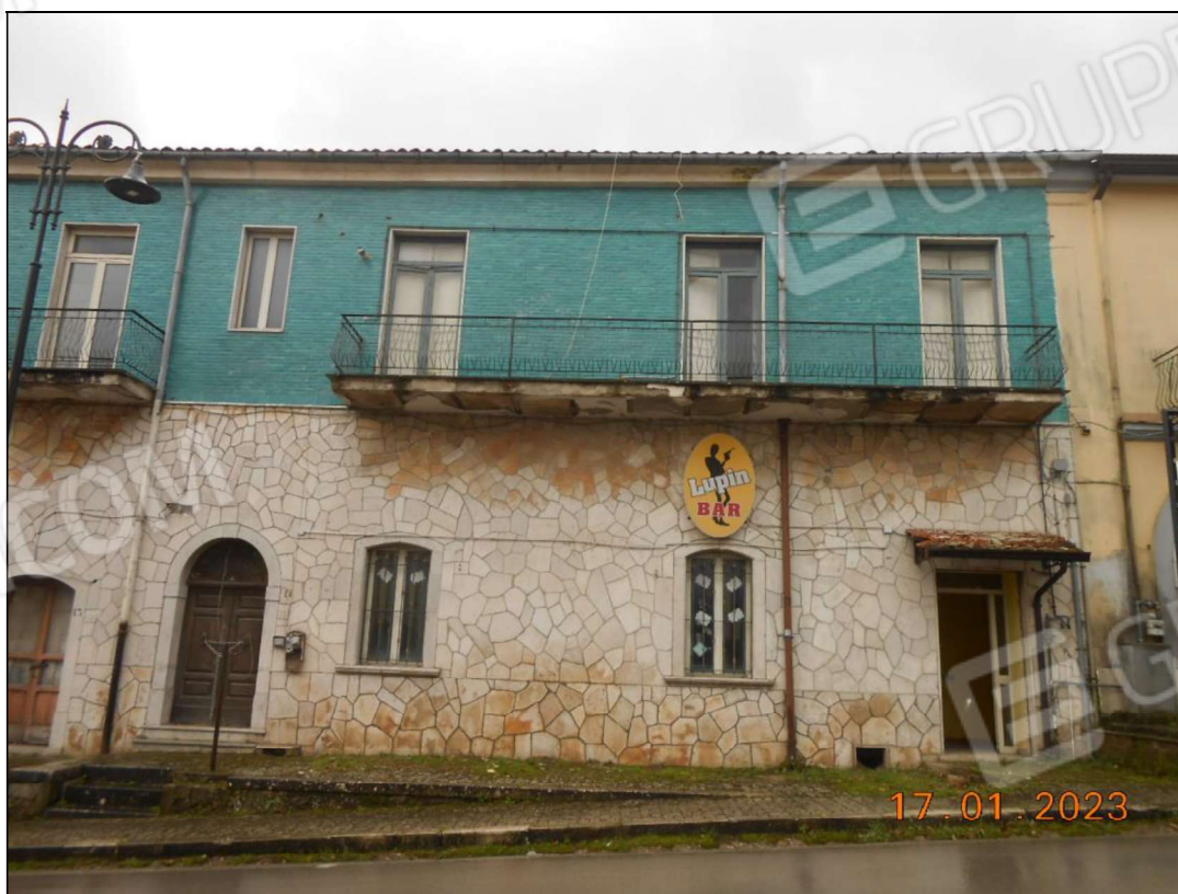
FOTO N. 04 Vista dell'immobile pignorato.
