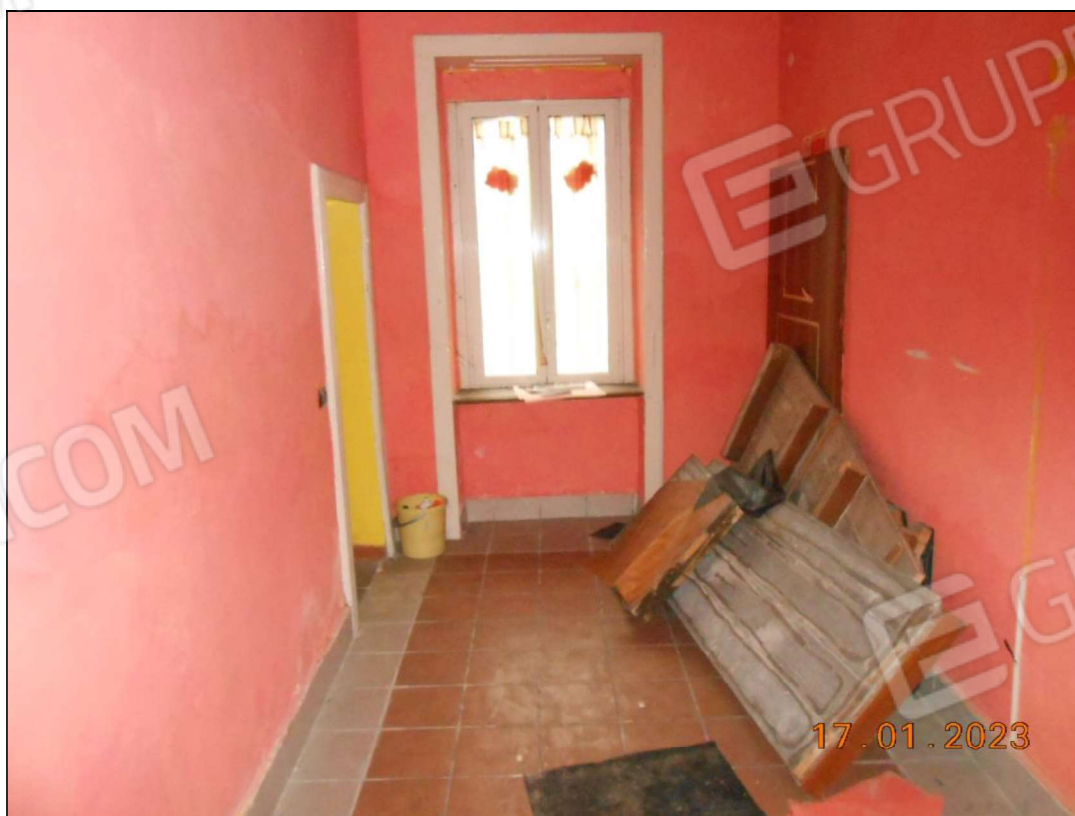
FOTO N. 22 Vista interna del piano terra.
