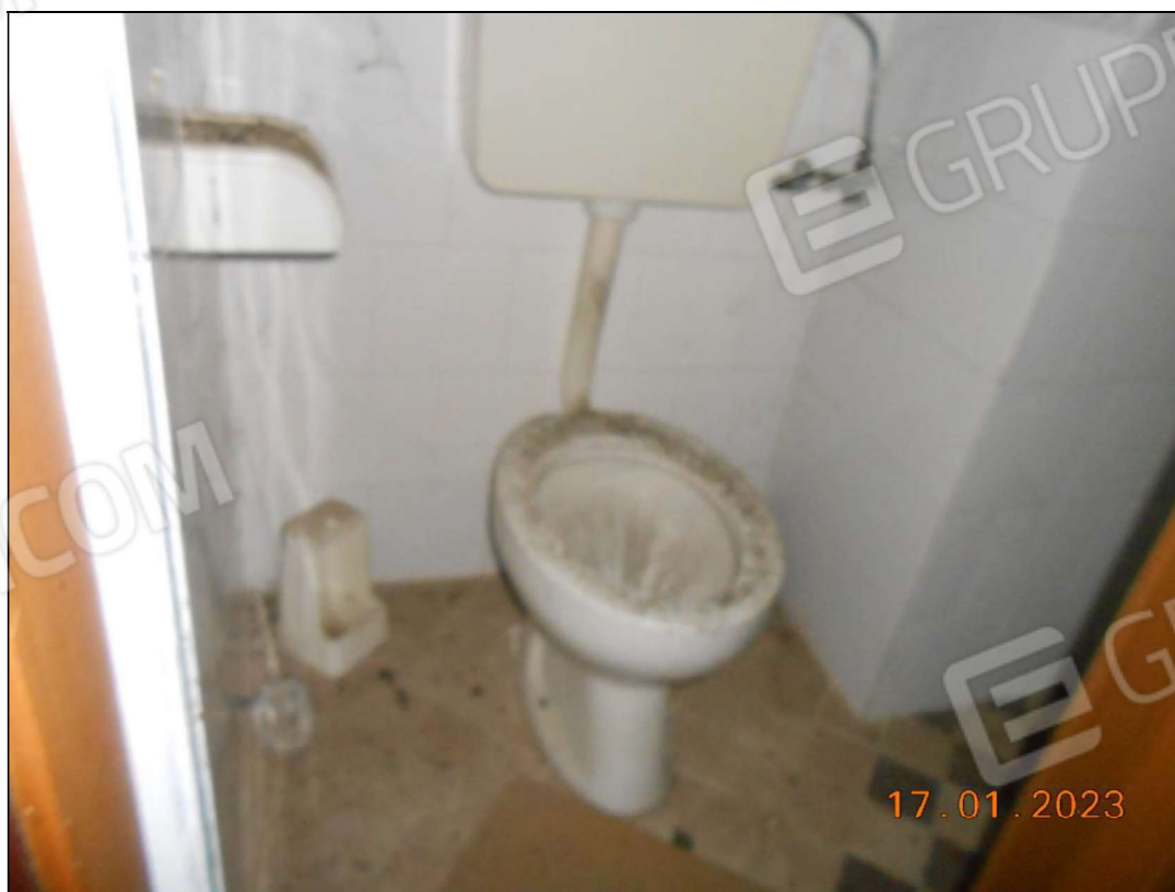
FOTO N. 36 Vista del w.c. a piano terra.
