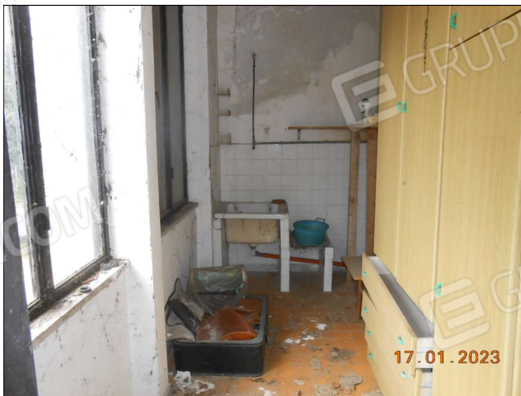
FOTO N. 56 Vista della lavanderia al piano primo.
