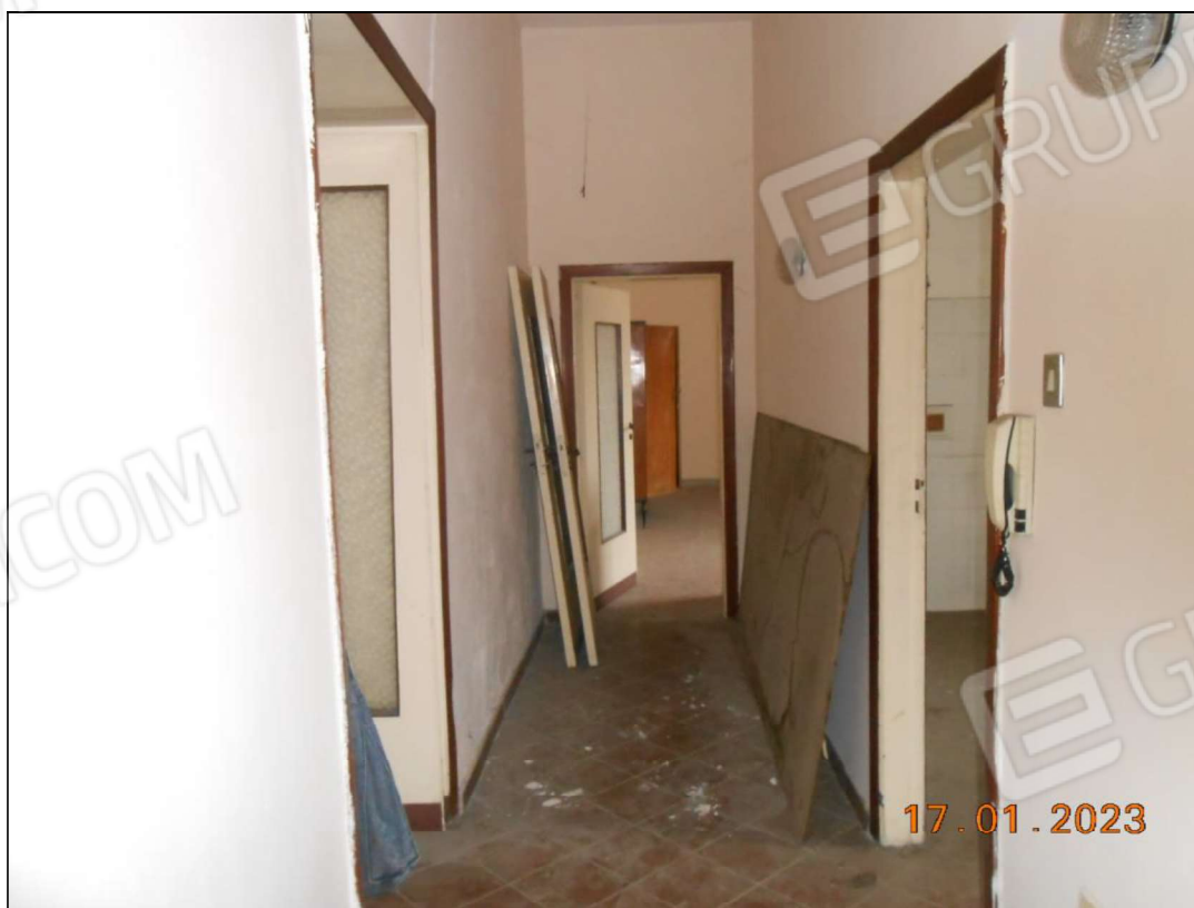
FOTO N. 46 Vista interna del piano primo.
