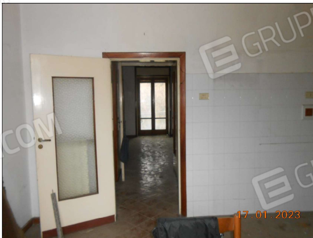
FOTO N. 48 Vista interna del piano primo.
