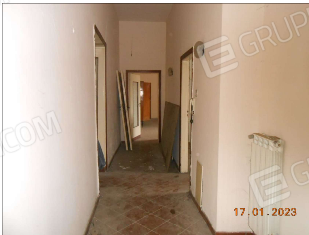
FOTO N. 44 Vista interna del piano primo.
