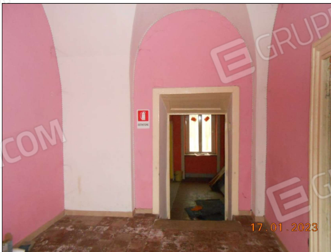
FOTO N. 26 Vista interna del piano terra.
