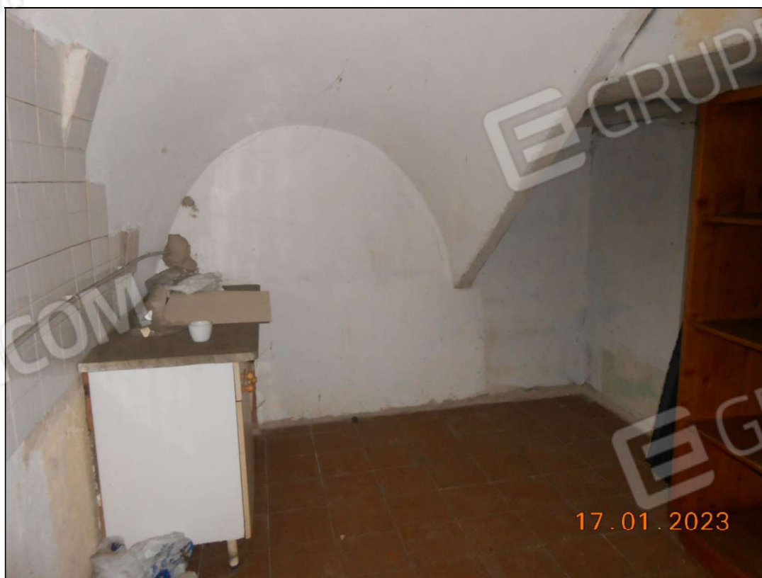
FOTO N. 30 Vista interna del piano terra.
