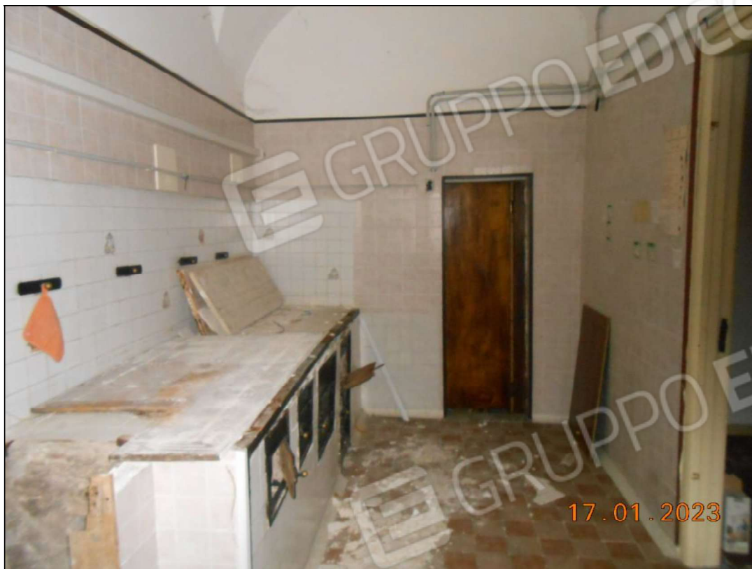
FOTO N. 29 Vista interna del piano terra.
