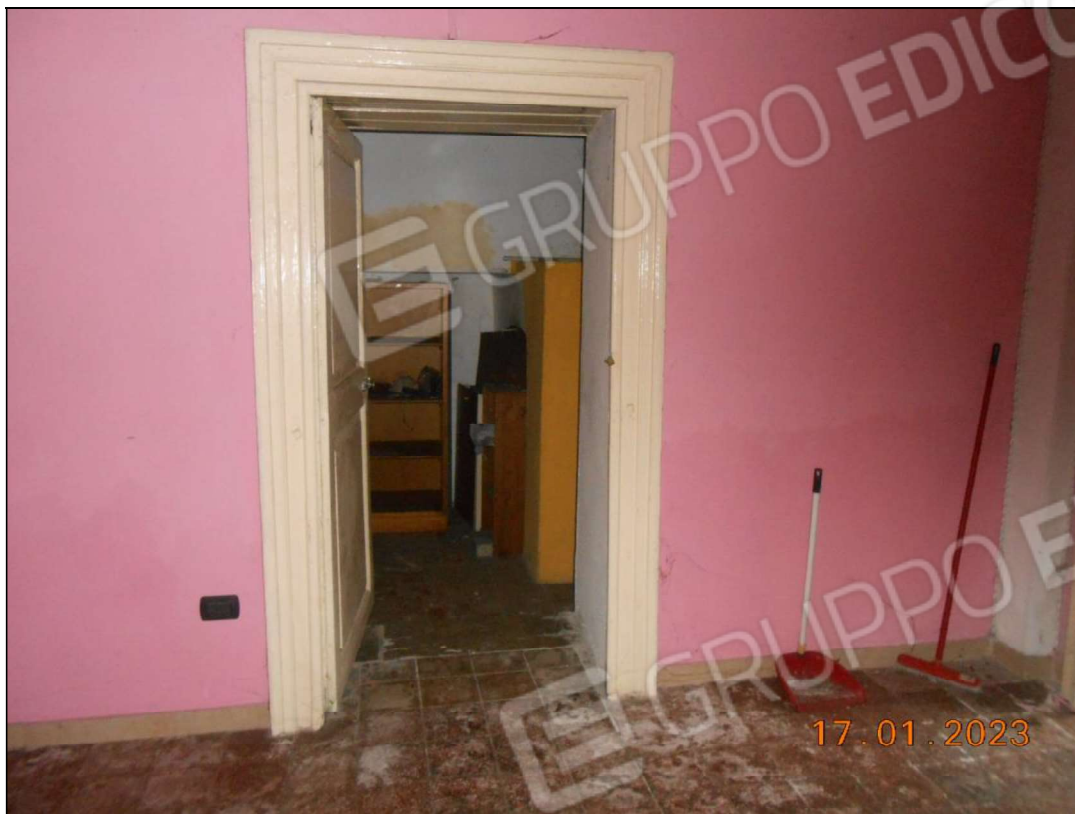
FOTO N. 27 Vista interna del piano terra.
