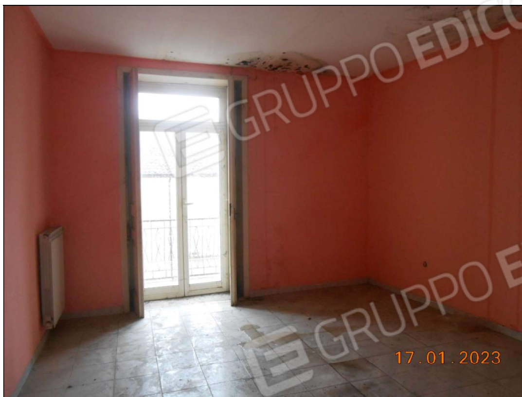
FOTO N. 43 Vista interna del piano primo. Si notano diffuse infiltrazioni sul soffitto e l'acqua sul pavimento
