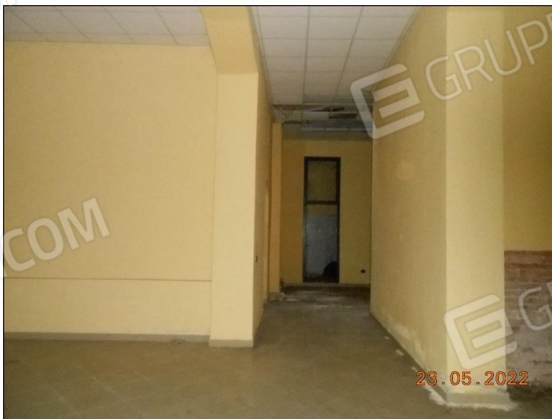
FOTO N. 14 Vista interna dei locali posteriori dell'immobile.
