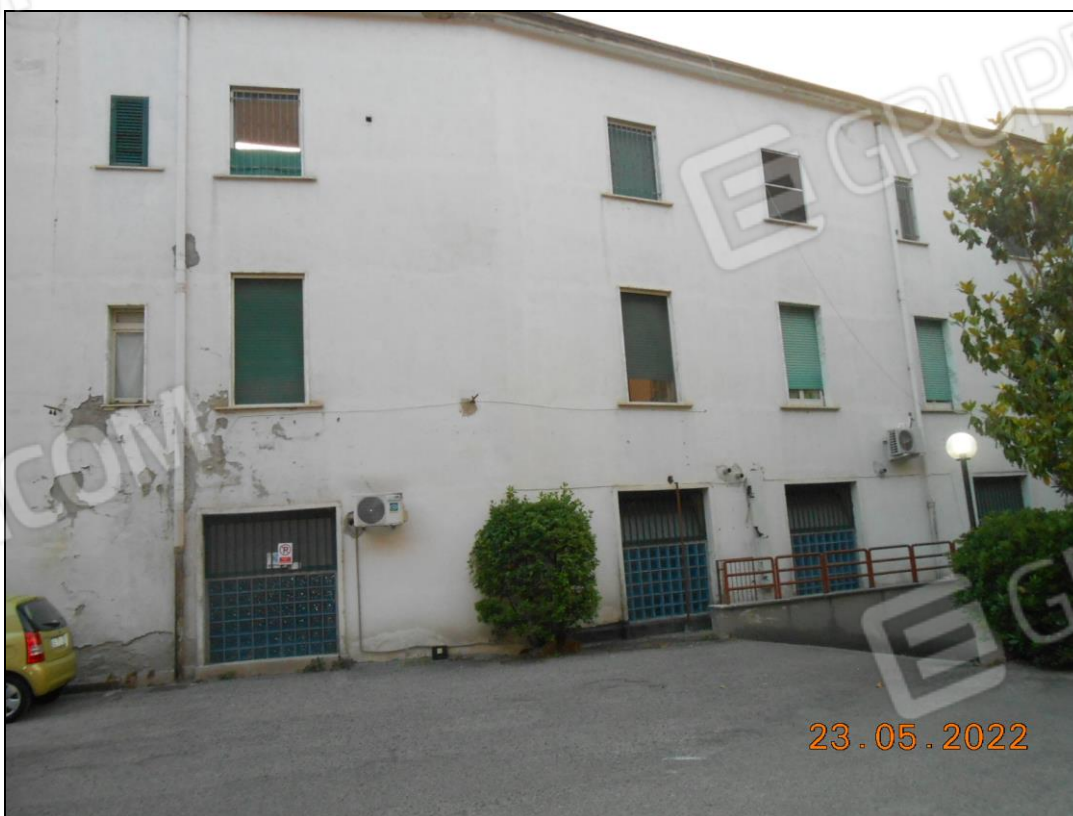
FOTO N. 52 Vista posteriore del fabbricato.
