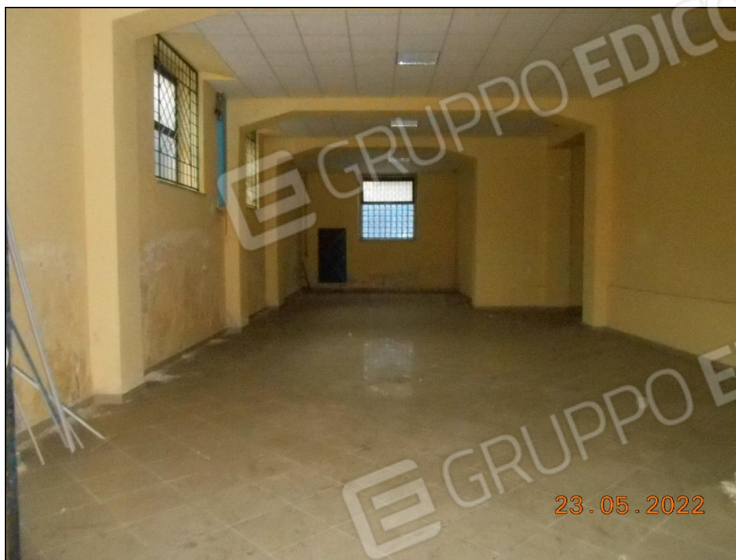
FOTO N. 13 Vista interna dei locali posteriori dell'immobile.
