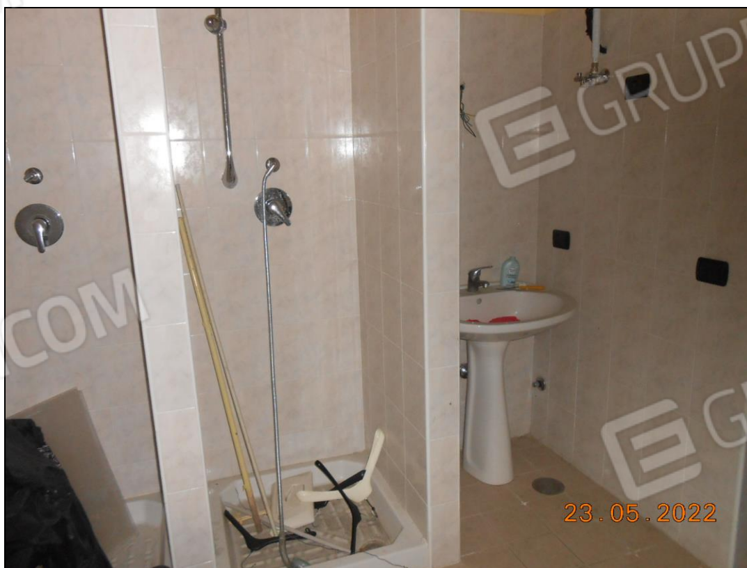
FOTO N. 34 Vista interna dei locali dell'immobile.
