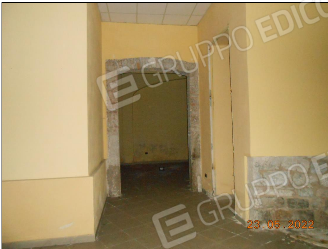
FOTO N. 39 Vista interna dell'immobile.
