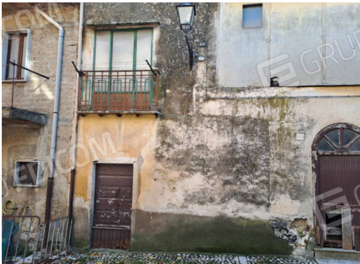
FOTO N. 4 VISTA PARZIALE DEL PROSPETTO RETROSTANTE PROSPETTANTE SU SPAZIO PUBBLICO
