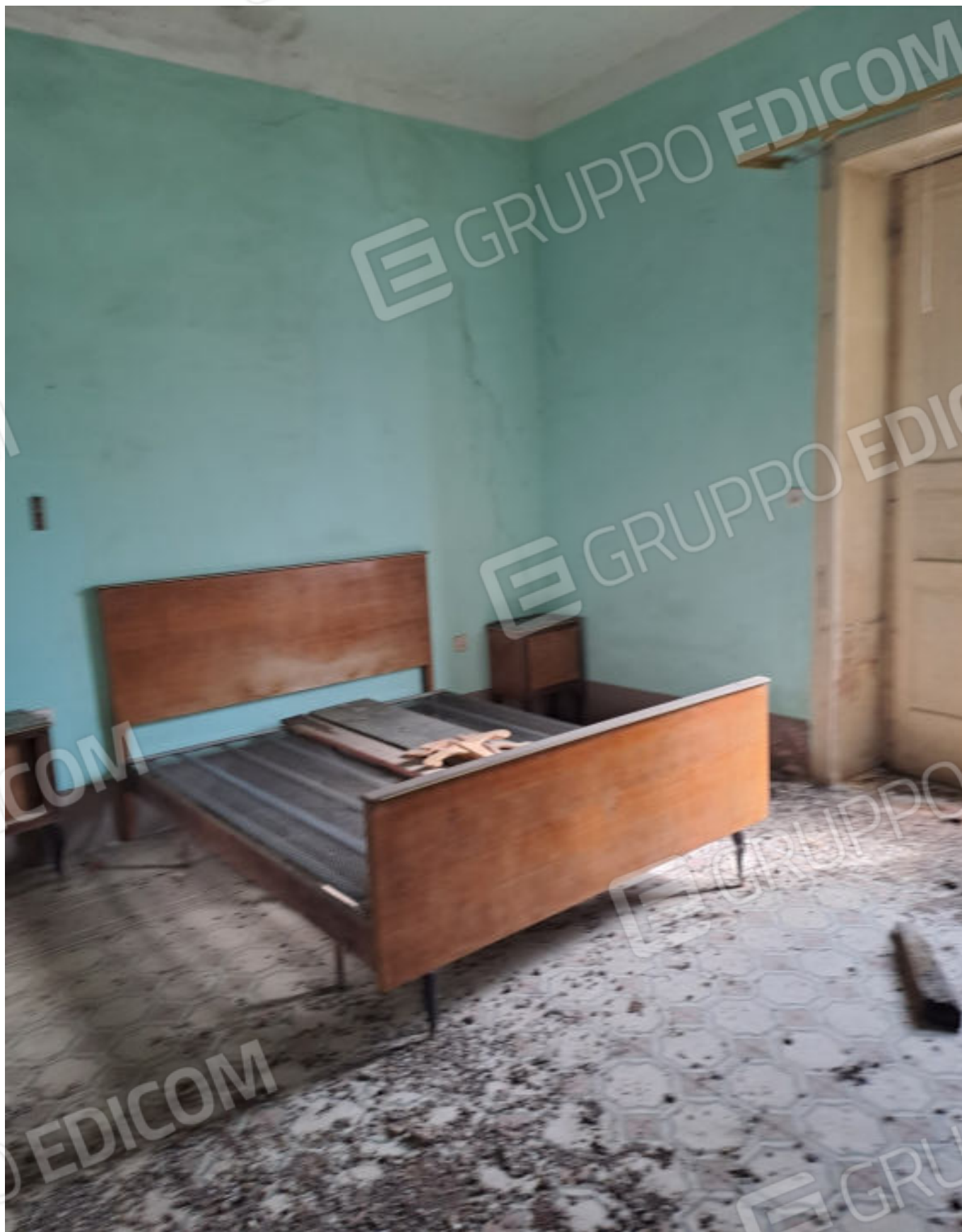
FOTO N. VISTA DEL LOCALE LETTO AL SECONDO PIANO
