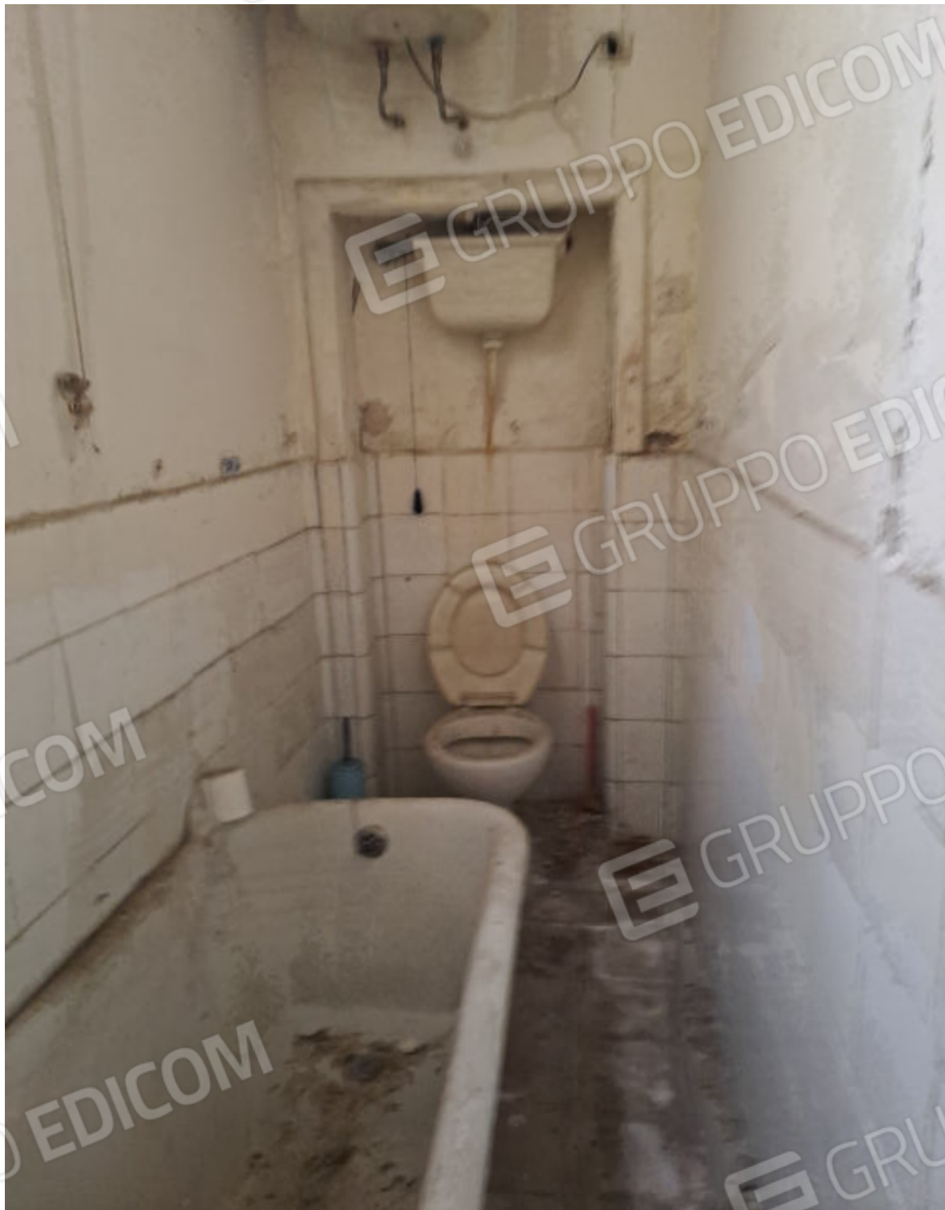
FOTO N. 7 VISTA DEL LOCALE BAGNO DEL PIANO PRIMO
