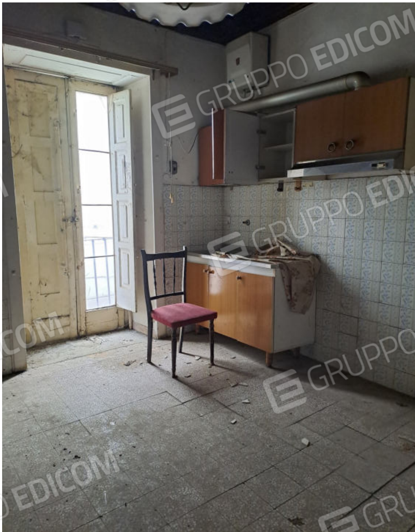
FOTO N. 6 VISTA DEL LOCALE CUCINA
