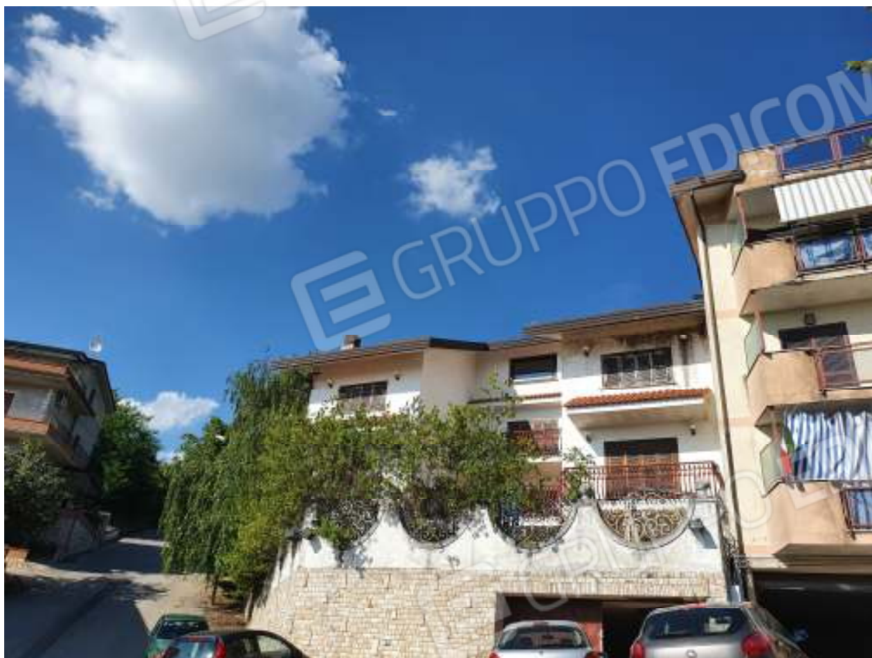
Foto n. 1: Villa unifamiliare – Prospetto principale lungo via Sant’Anna lato ovest, ingresso garage al piano seminterrato
