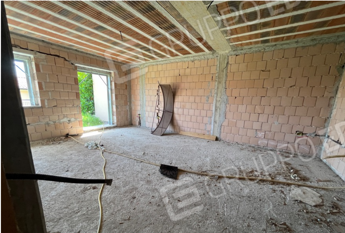
Fig.16 – Vista di un vano interno a rustico
