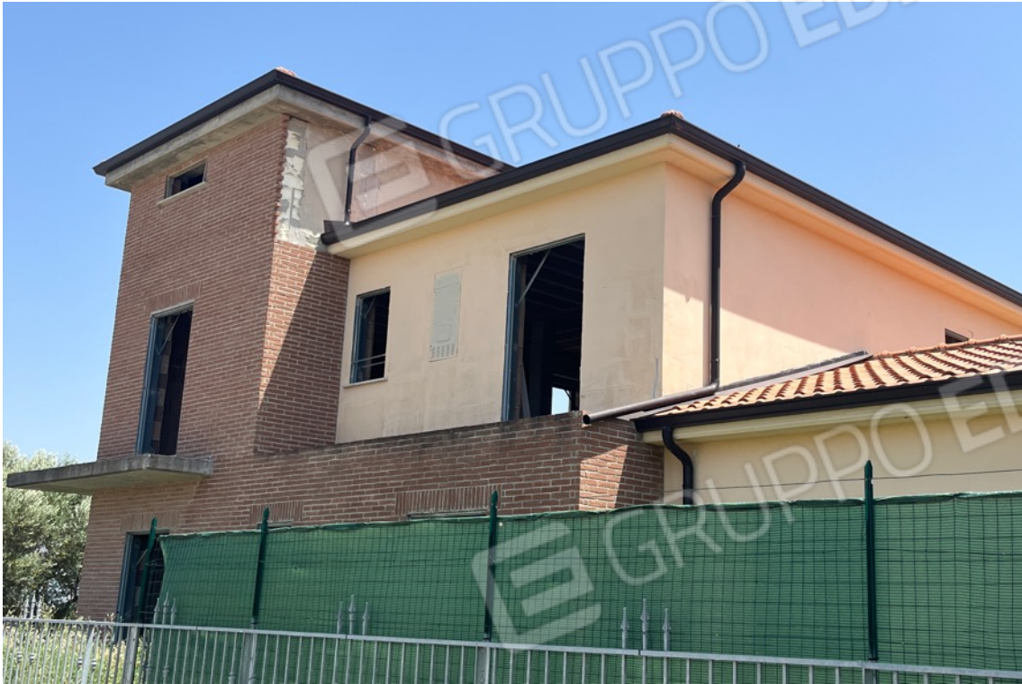
Fig.3 – Vista della facciata dell’Immobile (fronte nord-ovest)
