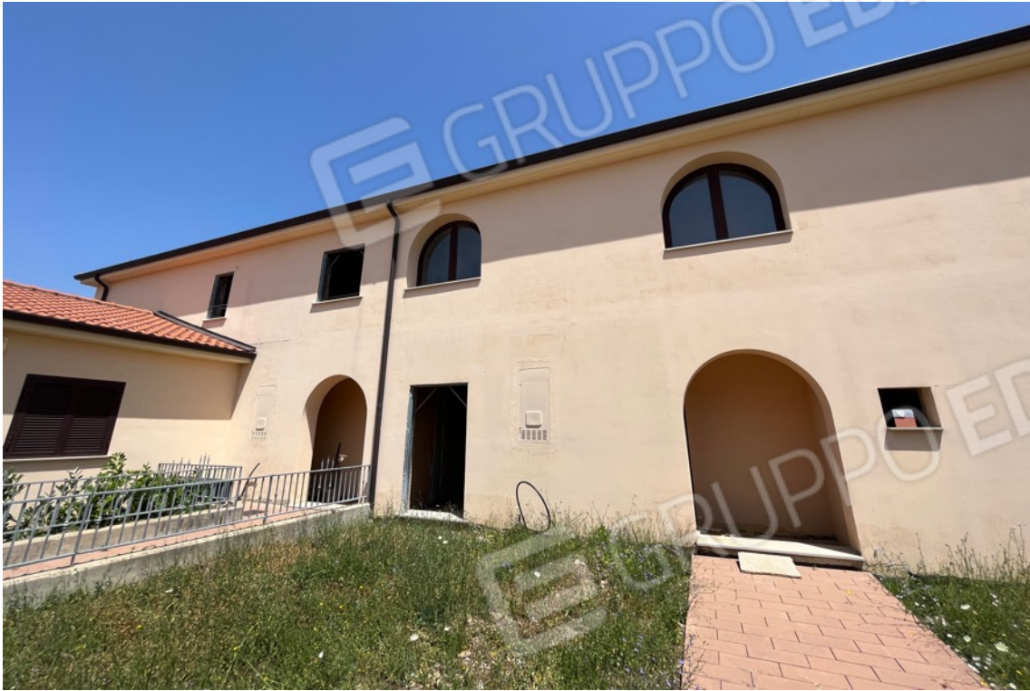
Fig.8 – Vista della facciata (fronte sud)
