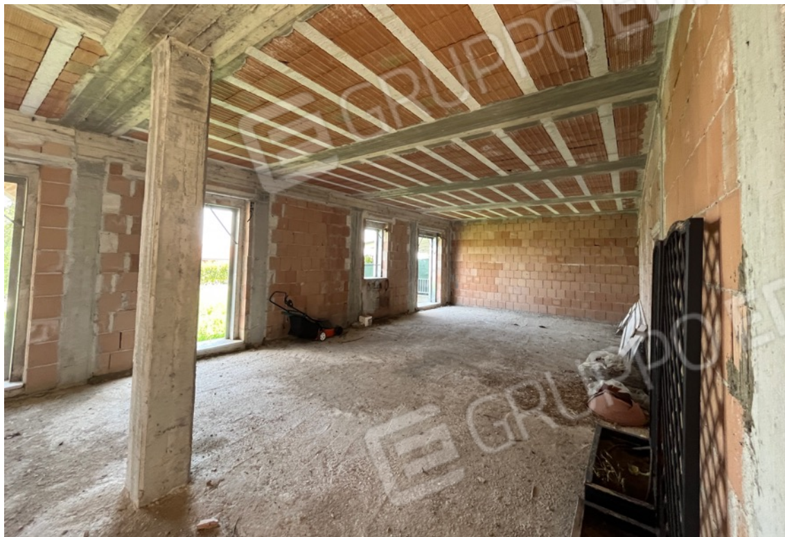
Fig.14 – Vista dei vani interni a rustico
