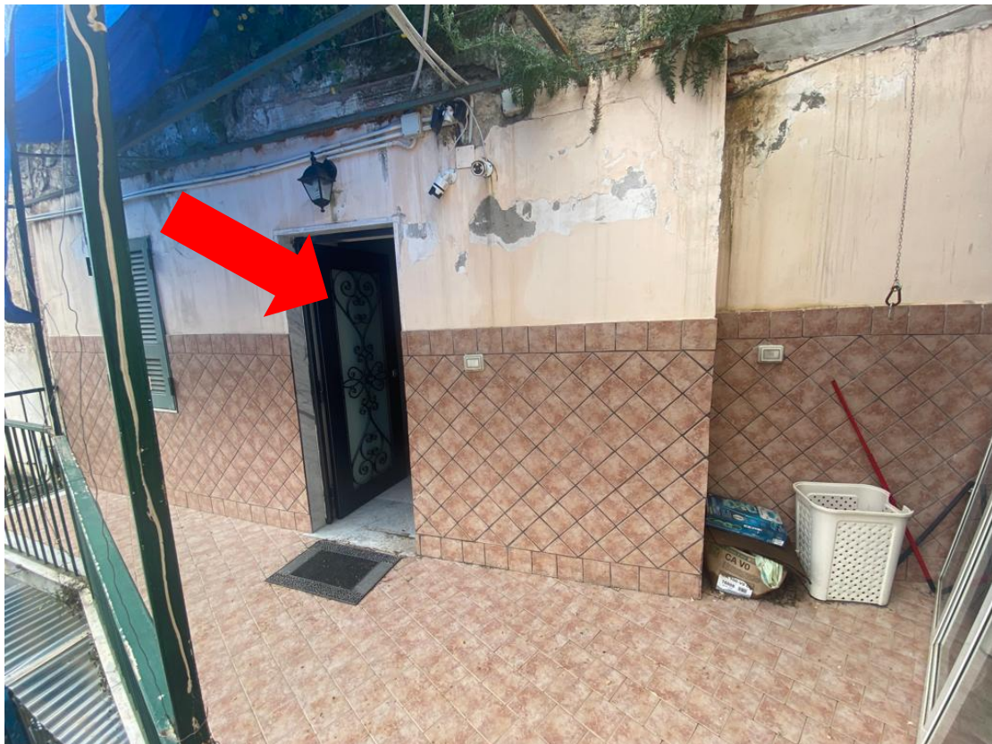
Figura 6 Ingresso all'immobile dal balcone terrazzato B1
