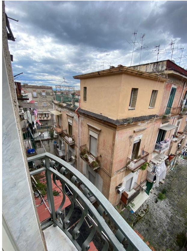
Figura 19 particolare dal balcone B5
