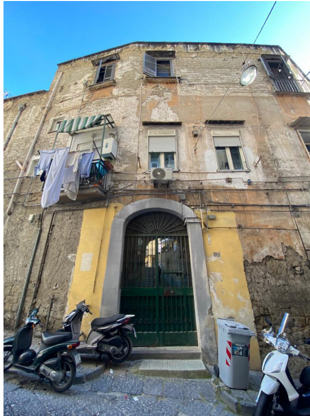
Figura 1 Ingresso al fabbricato
