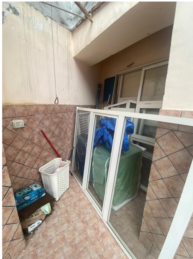
Figura 20 particolare del ripostiglio posto sul balcone B1
