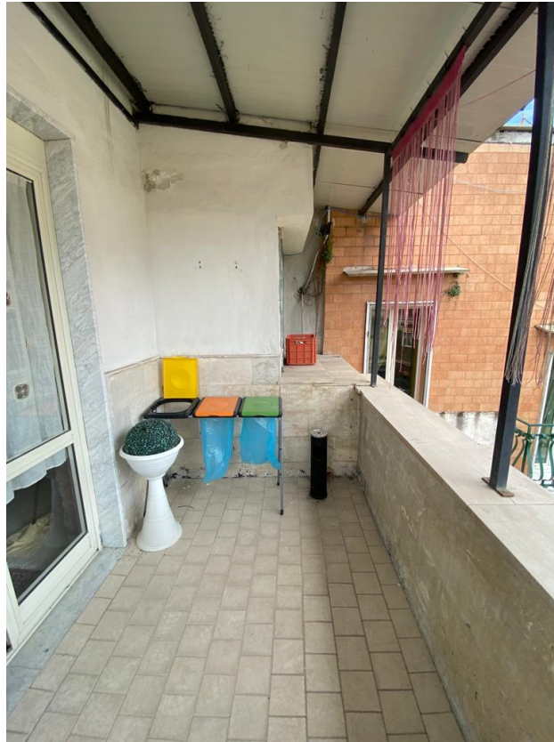
Figura 17 particolare Balcone B2
