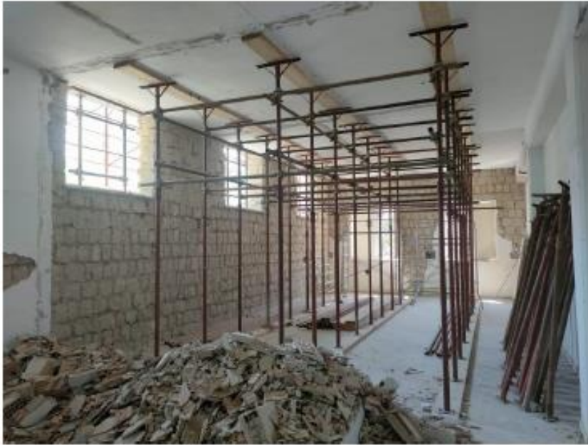
Vista del solaio del secondo impalcato (tipo SAP) oggetto di puntellamento, visto lo stato di avanzato dissesto, propedeutico al successivo rifacimento.
