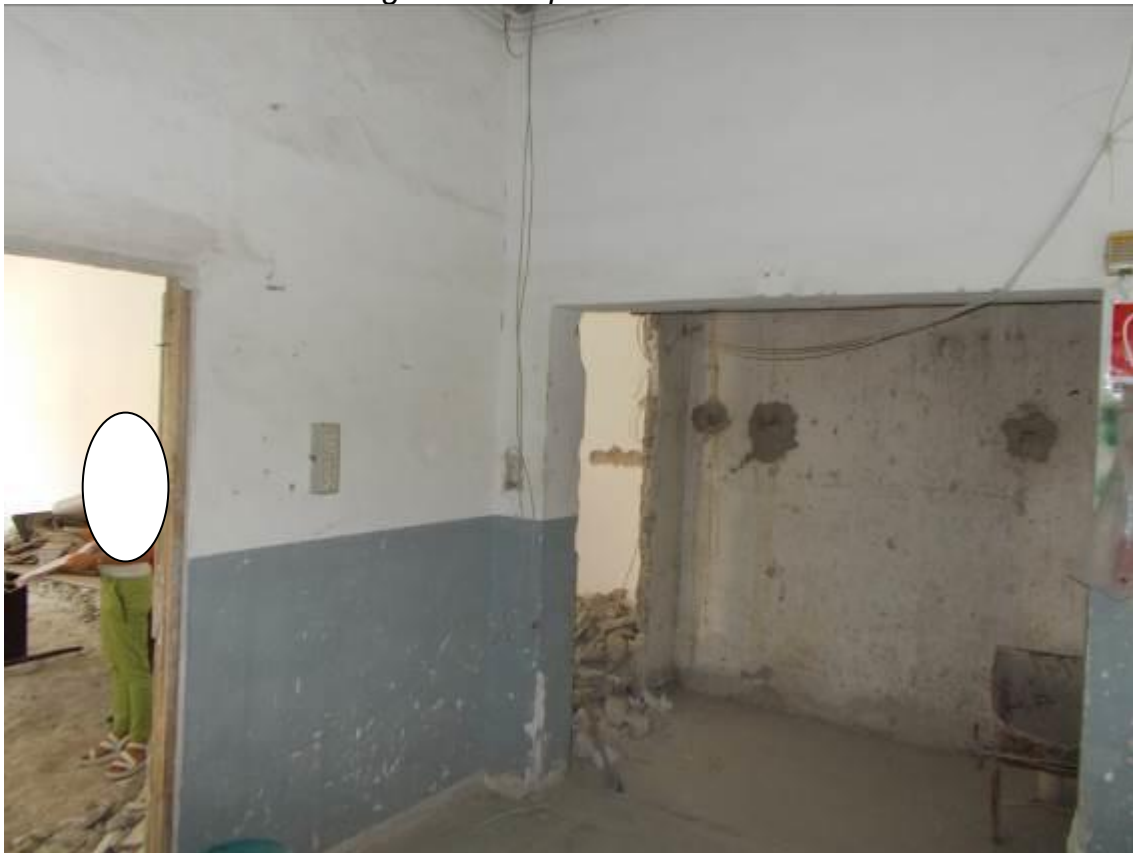
Foto 17 - Locale D e Locale E
