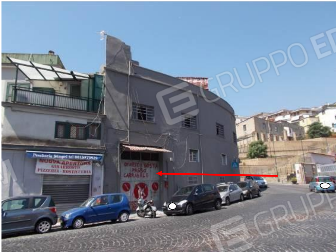
Foto 01 – L'accesso al fabbricato dalla via Ponti Rossi
