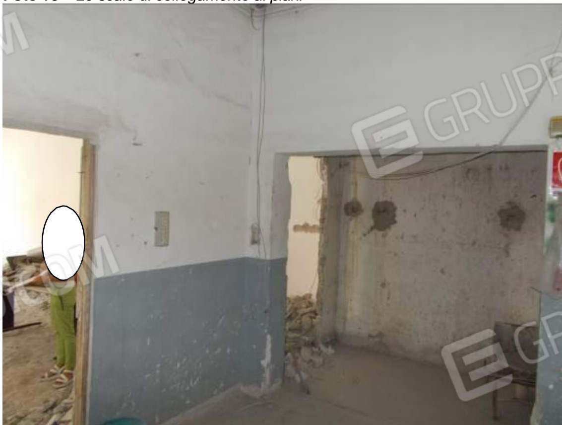
Foto 17 - Locale D e Locale E
