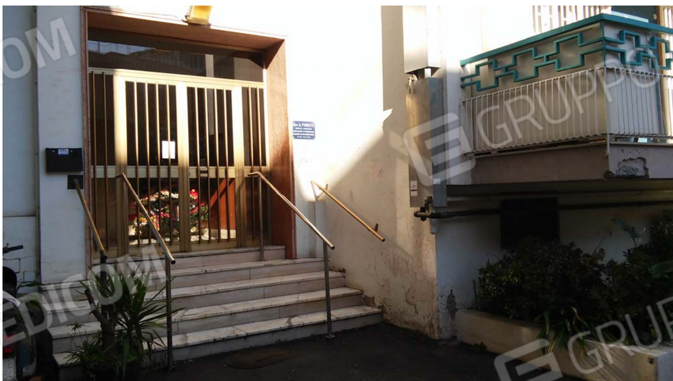
Foto 6 – Portone di accesso al fabbricato della scala “B”
