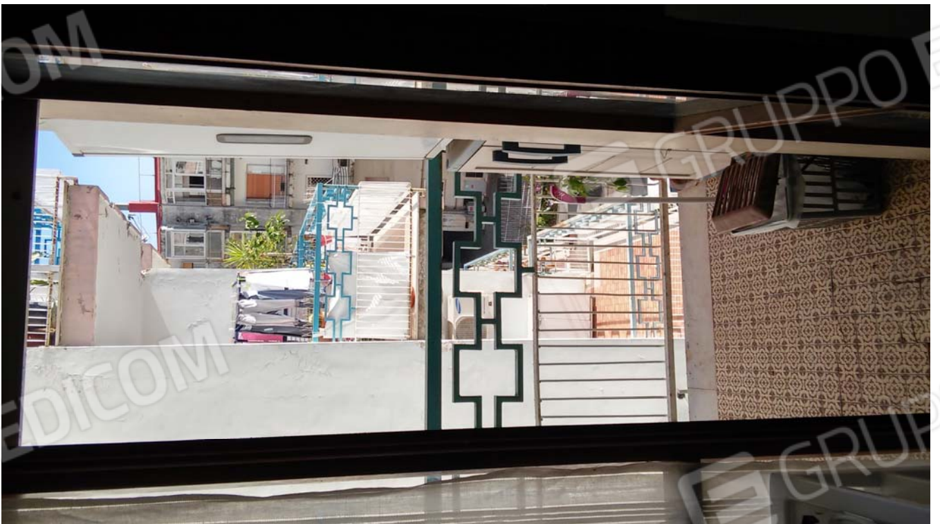
Foto 14 – Balcone esposto ad est prospiciente l'area esterna antistante gli accessi al fabbricato a cui si accede dalla cucina
