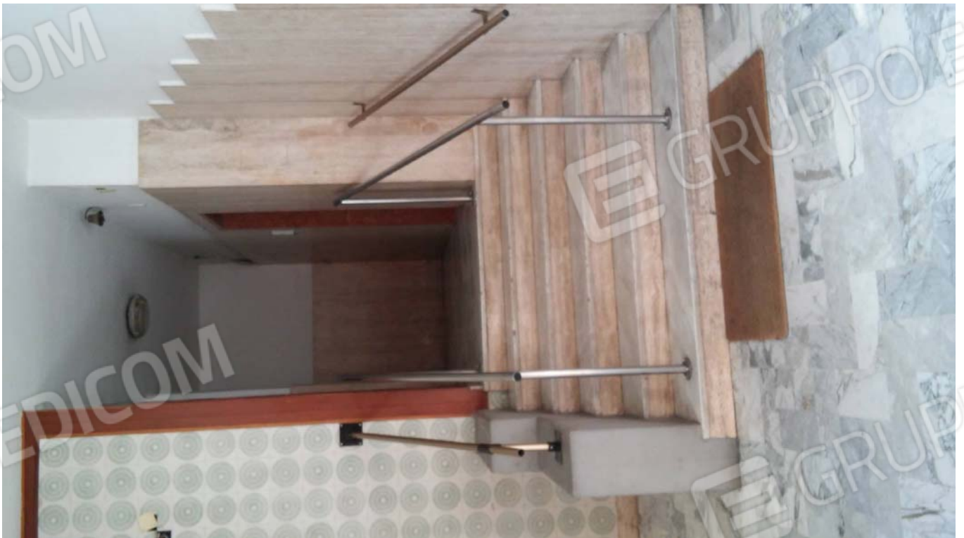
Foto 8 – Androne della scala “B” del fabbricato
