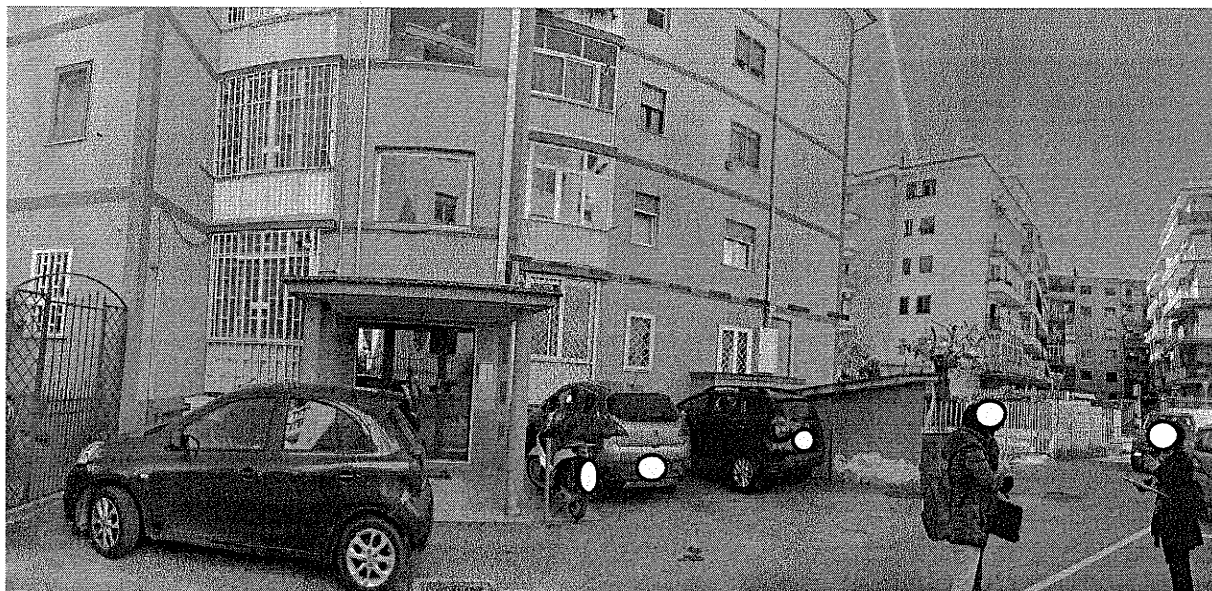
FOTO 4 - Il fabbricato visto dall'aera condominiale.
