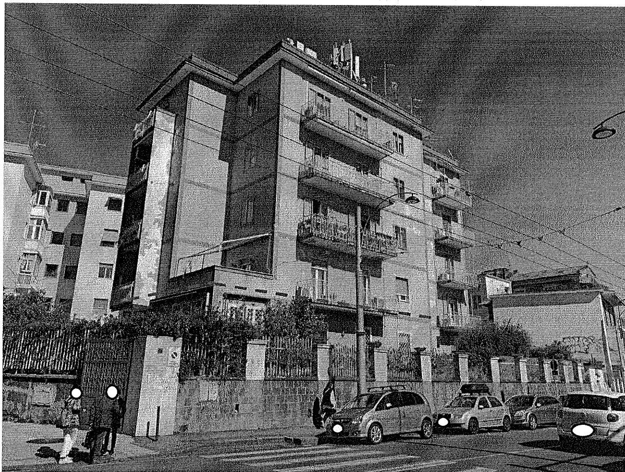
FOTO 1 - Il fabbricato dal viale Colli Aminei
