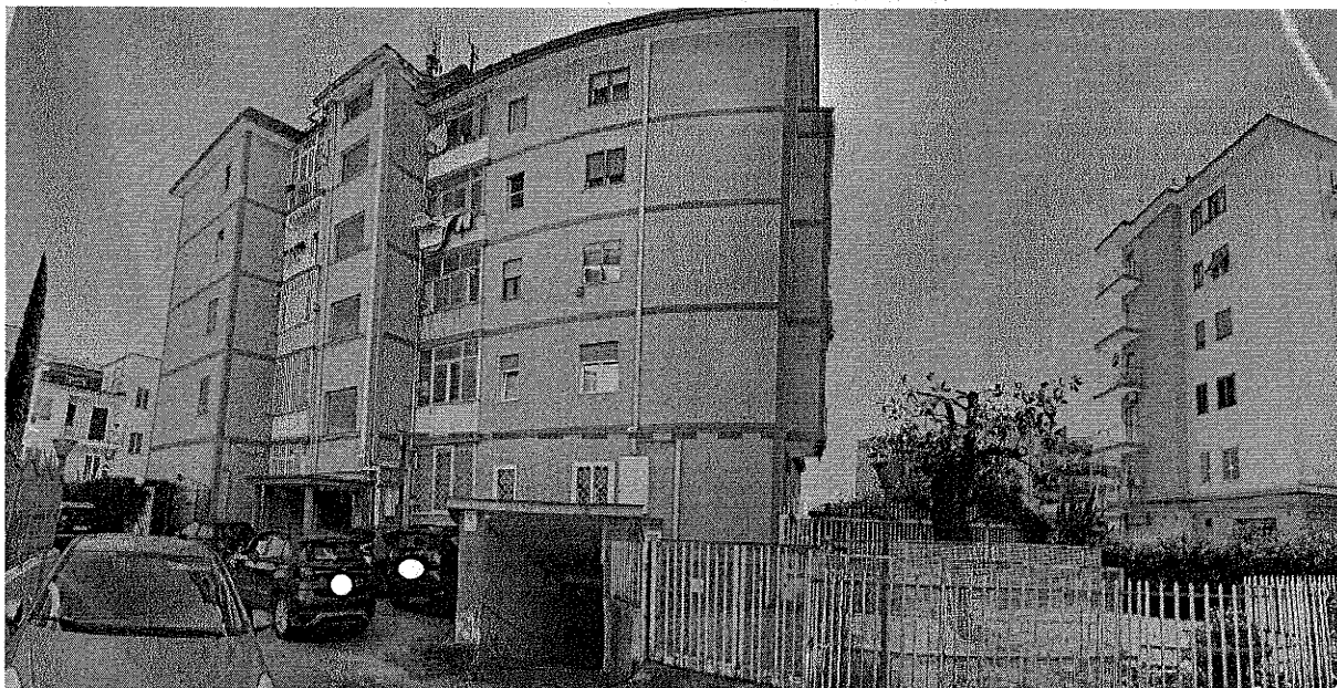
FOTO 3 - Il fabbricato visto dall'aera condominiale.
