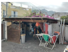
Foto n. 2 - Corte pertinenziale di accesso dalla via Morgera - Tettoia
