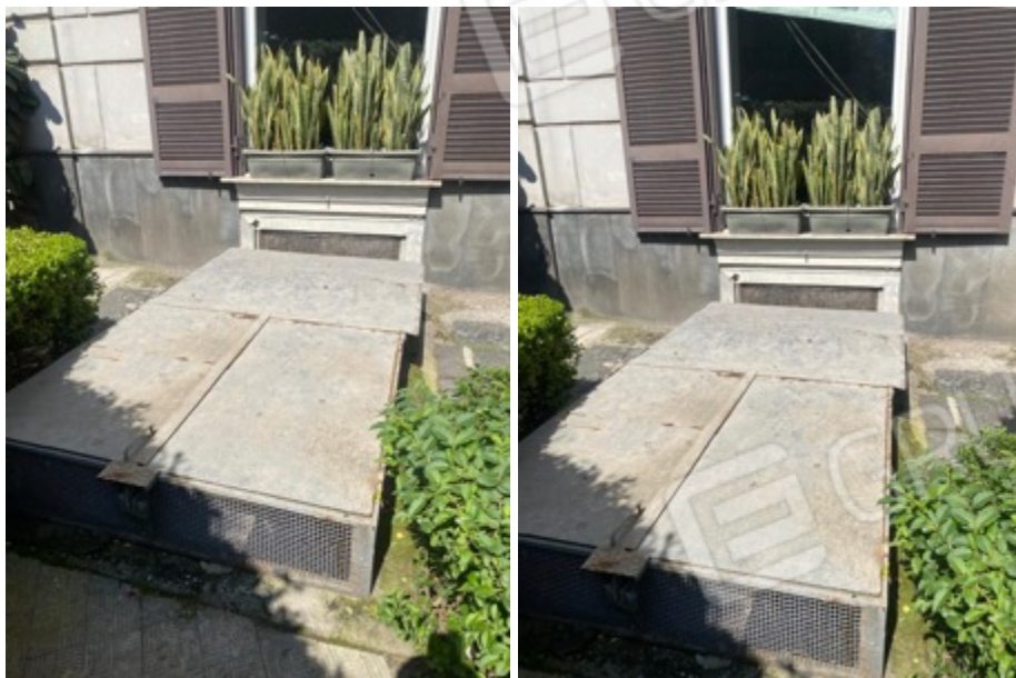
Foto da 2 a7 : Vista struttura in ferro e botola d'ingresso al locale deposito
