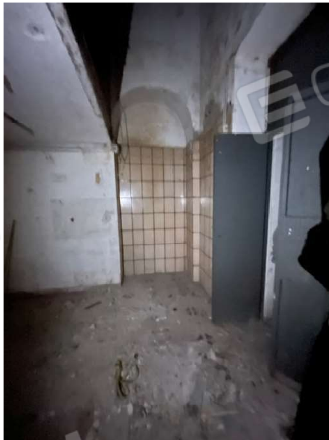
Foto 10 – Vista interna del vano principale soppalcato
