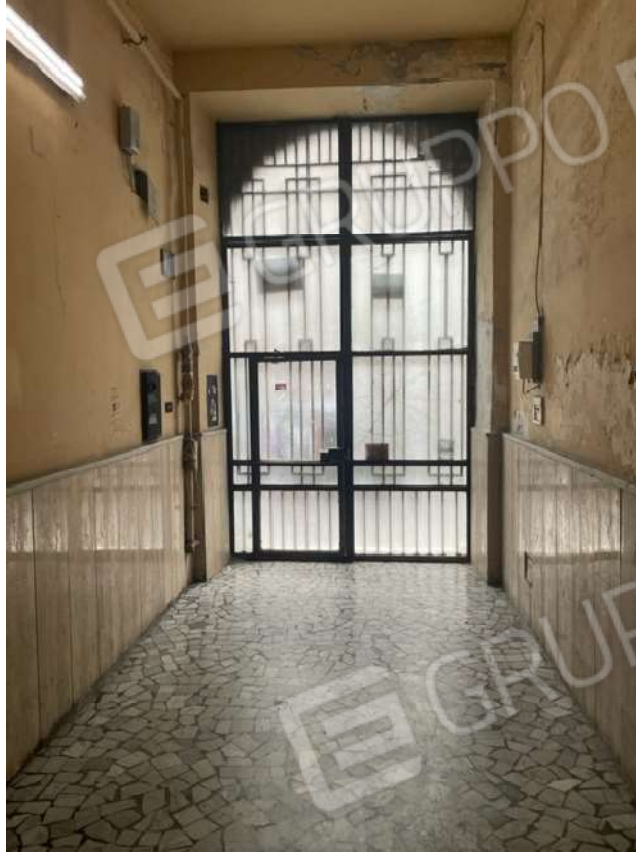
Foto 5 - Vista interna: androne
