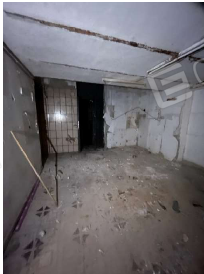
Foto 8 – Vista interna del vano principale soppalcato
