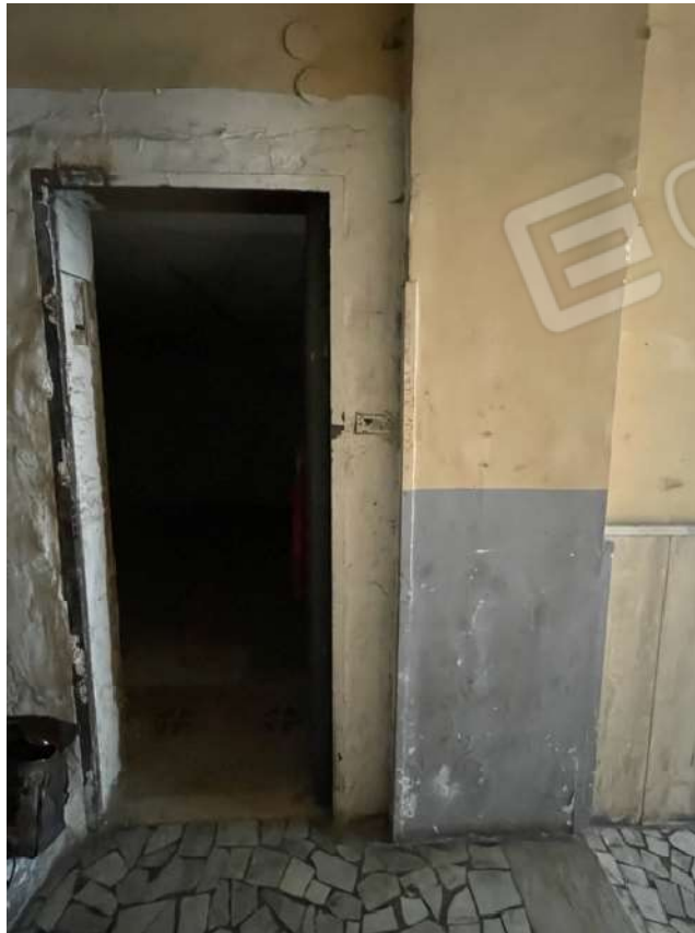
Foto 6 - Vista interna: porta di ingresso al locale terraneo
