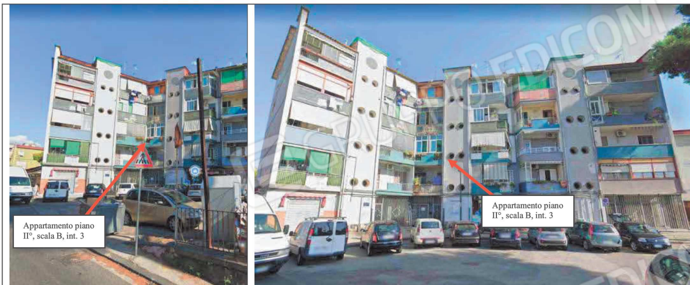
Foto 4, 5: Viste fabbricato da Via Lago Lucrino
