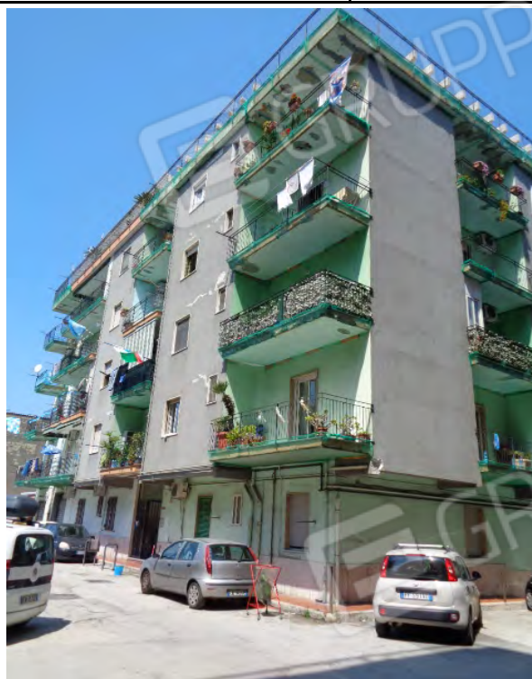
FOTO 3 Veduta del fabbricato in cui è ubicato il bene da viale interno al lotto
