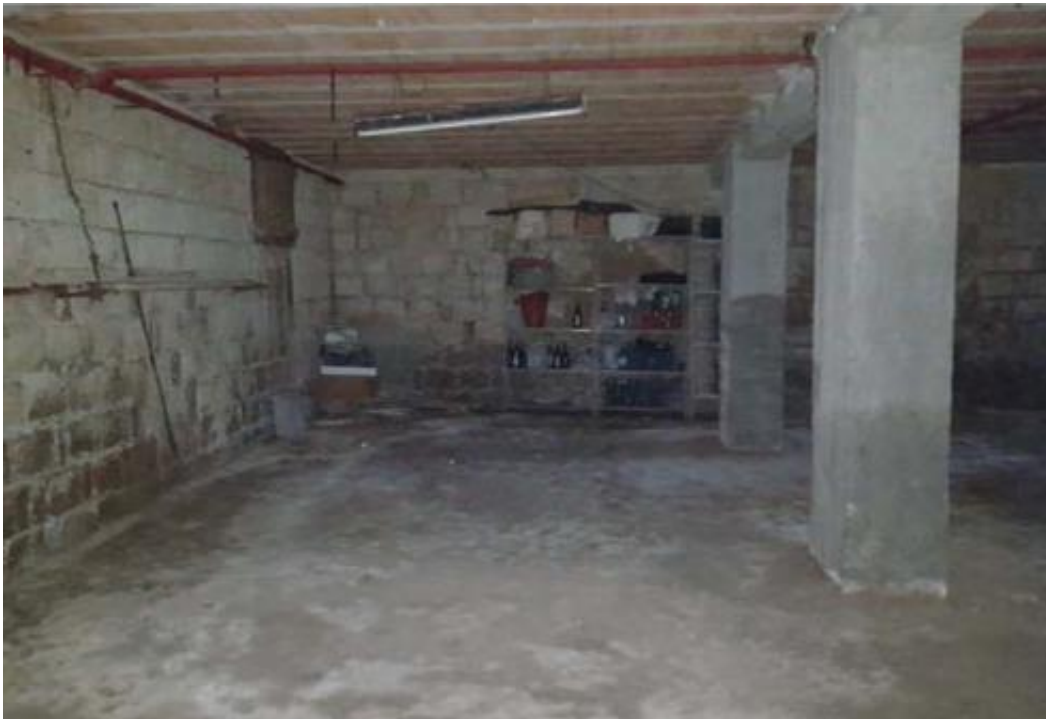
Fig. 10 - Interni magazzino - deposito
