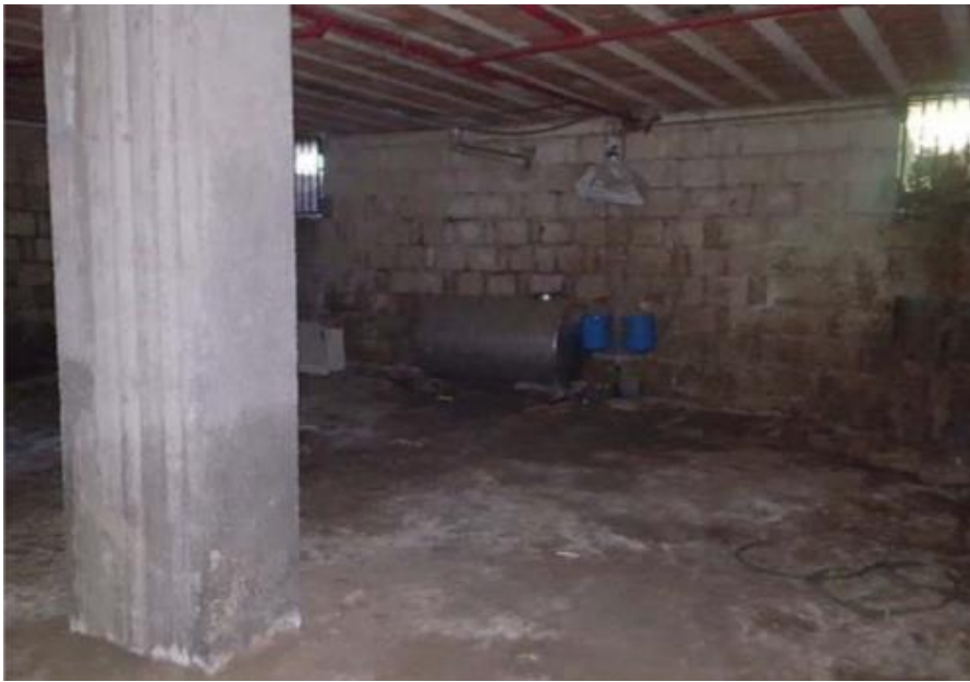
Fig. 11 - Interni magazzino - deposito
