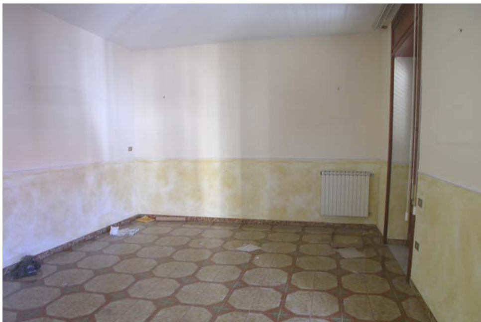
Fig. 6 - Interni immobile al piano primo
