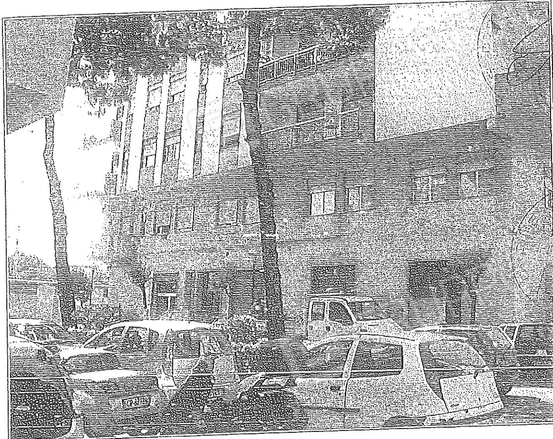
Foto N°3 – Fabbricato A Diamante
