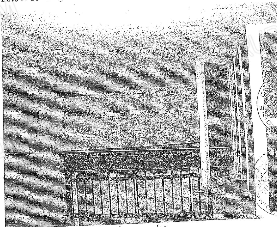
Foto N°19 - Negozio int. 22 - Piano soppalco
