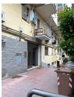
Foto 3 - Accesso al fabbricato in cui è ubicato l'immobile pignorato
