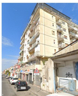
Foto 1 - Fabbriato in cui è ubicato l'immobile pignorato
