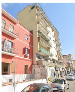
Foto 2 - Fabbriato in cui è ubicato l'immobile pignorato
