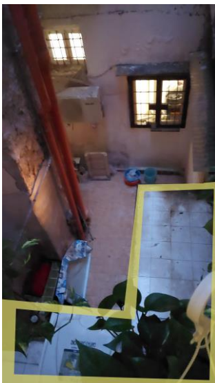
Cortile pertinenziale con presenza superfetazione soggetto terzo
