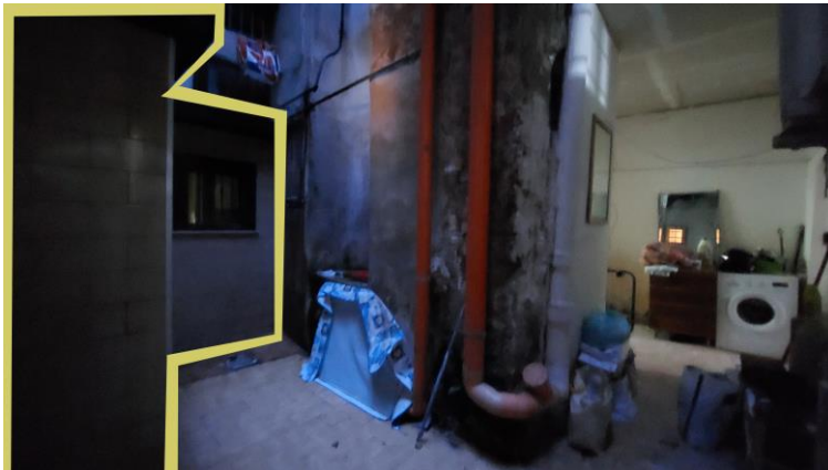
Cortile pertinenziale con presenza superfetazione soggetto terzo
