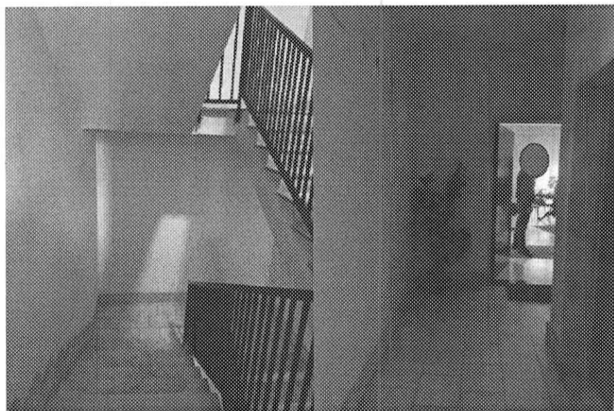
Foto da 1 a 3: Vista vano scala ed ascensore
