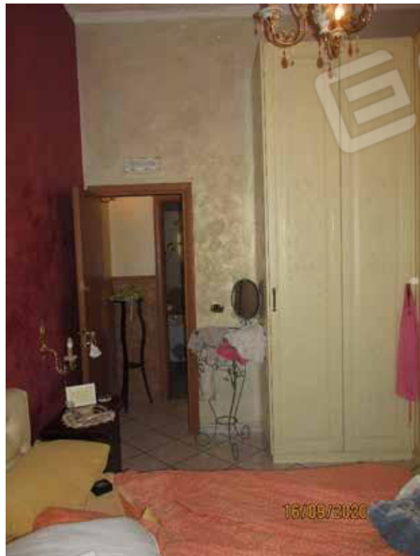
Fotografia 32 - Vano 2: La pavimentazione è costituita per tutta la sua superficie da piastrelle in gres porcellanato, le pareti risultano tinteggiate con pittura al quarzo decorativo per interni; il soffitto del solaio è rivestito da pittura a tempera.
