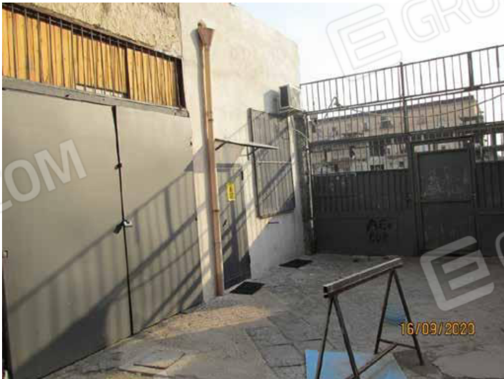
Fotografia 14: La pavimentazione del cortile comune, è costituita in basolato pesante di piperno vesuviano.
