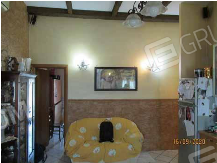
Fotografia 24 - Cucina/Soggiorno: in tutto l'ambiente le pareti risultano tinteggiate con pittura al quarzo decorativo per interni, nella parte bassa è rifinita con una "boiserie" costituita da un paramento sintetico ad eccezione della parte su cui si sviluppa l'angolo cottura che è rivestita da piastrelle di ceramica smaltata; il soffitto del solaio è rivestito con intonaci ordinari e rifinito con pittura a tempera.
