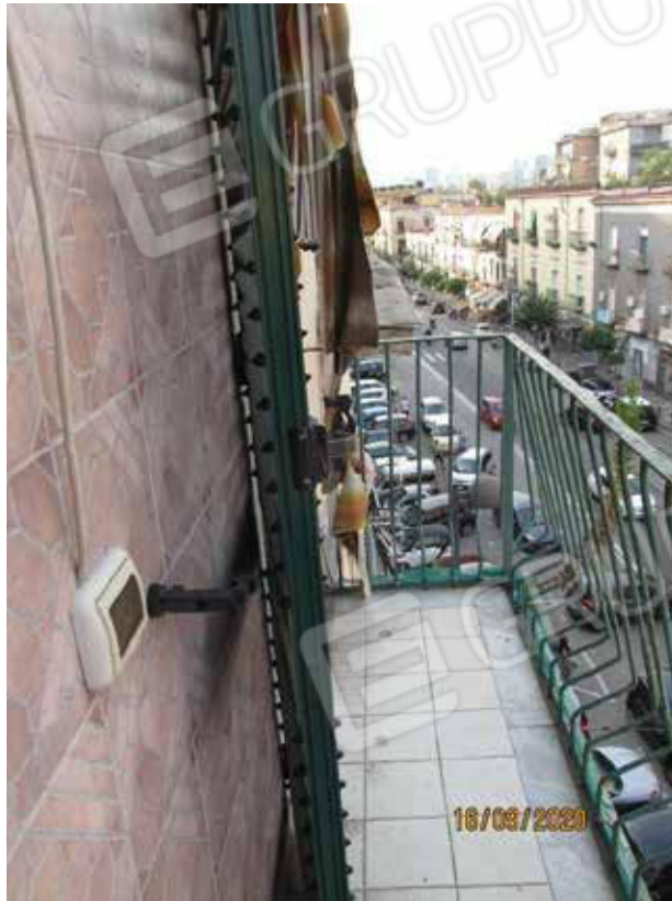
Fotografia 35 - Balconata: la pavimentazione è costituita per tutta la superficie da piastrelle in ceramica smaltata ed è protetta da una ringhiera in ferro.
