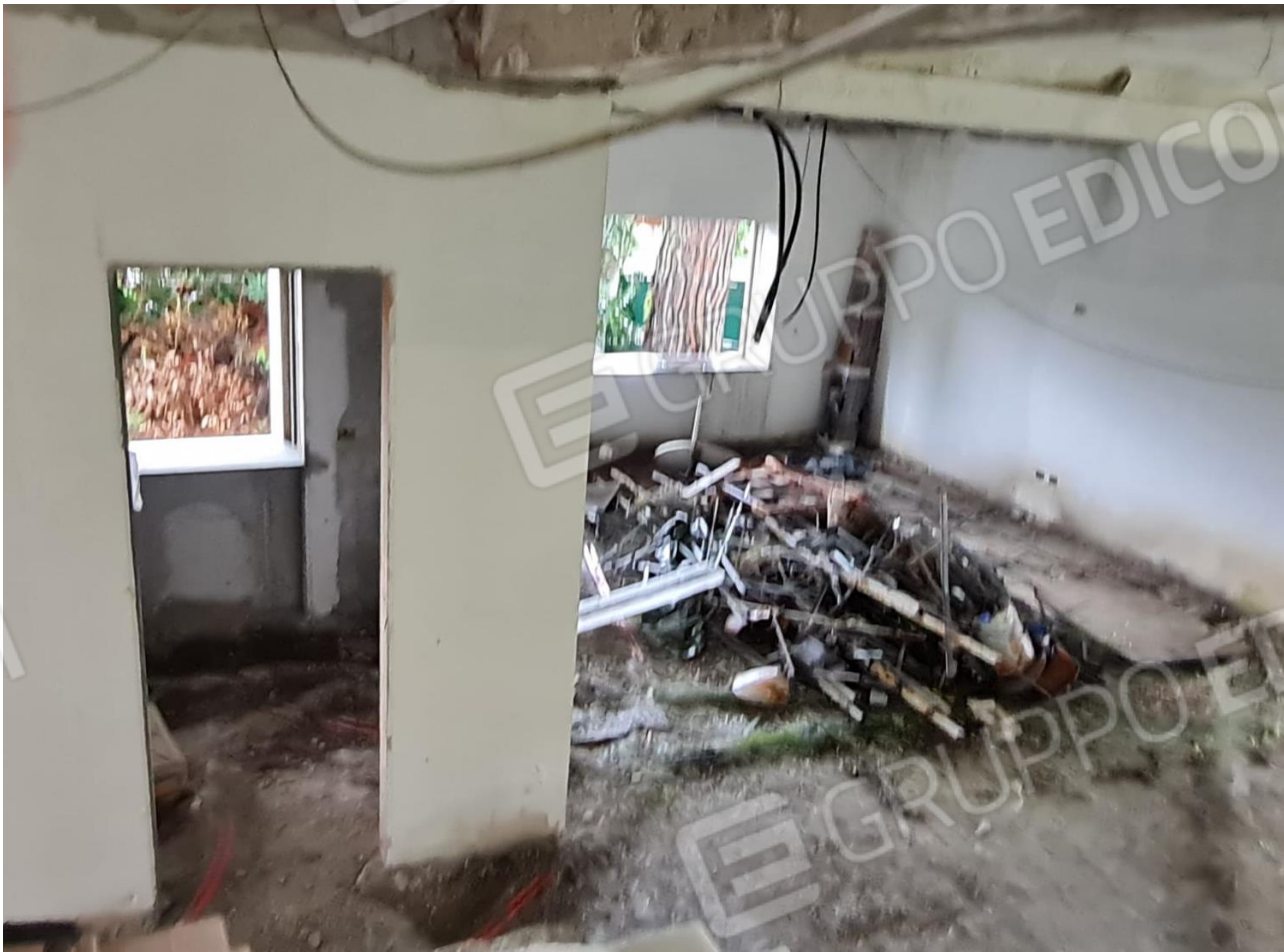
Vano (V1) e bagno (WC1)
