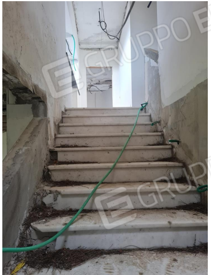
Scala interna di collegamento
