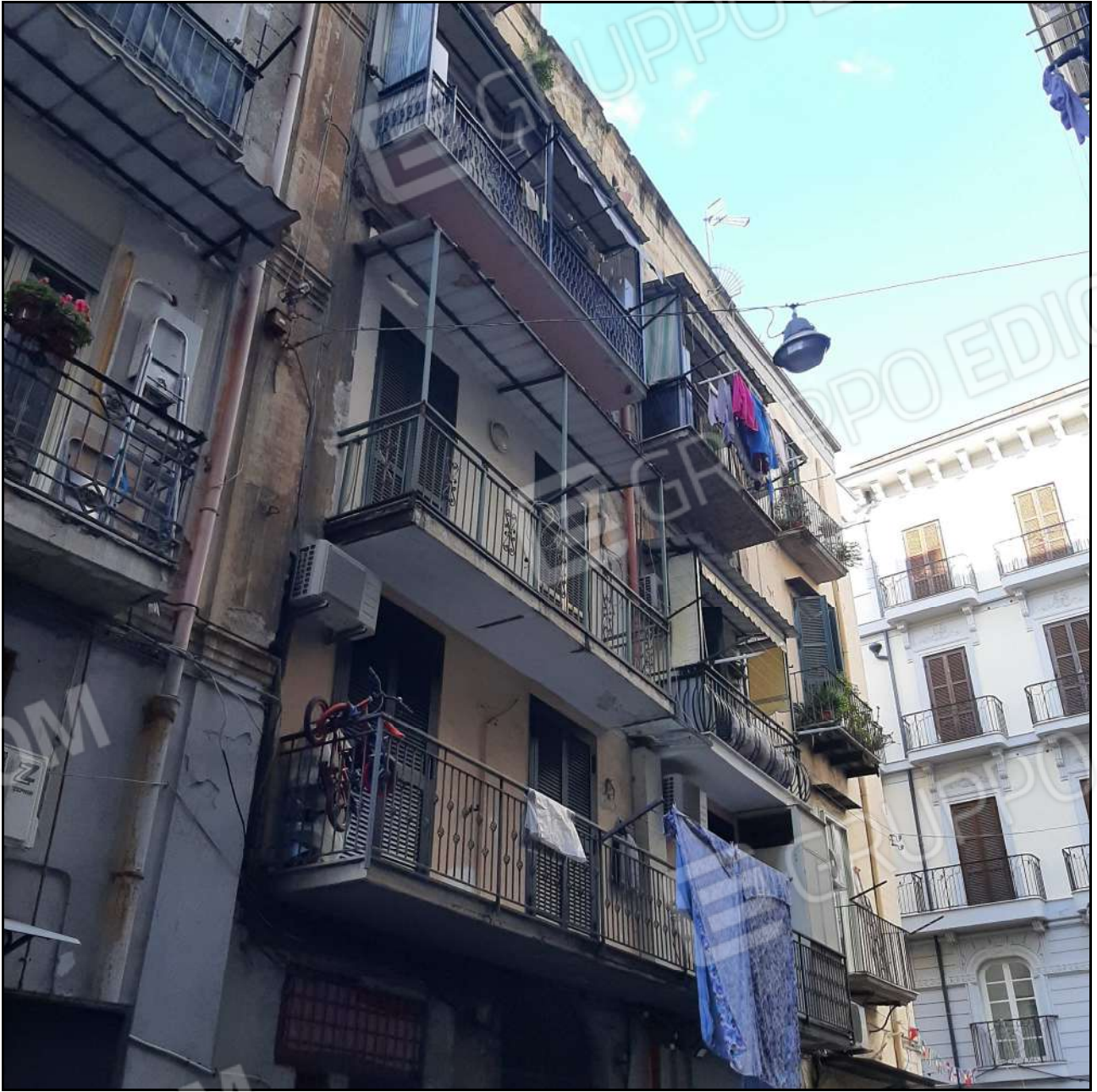
Facciata fabbricato civico n. 35
