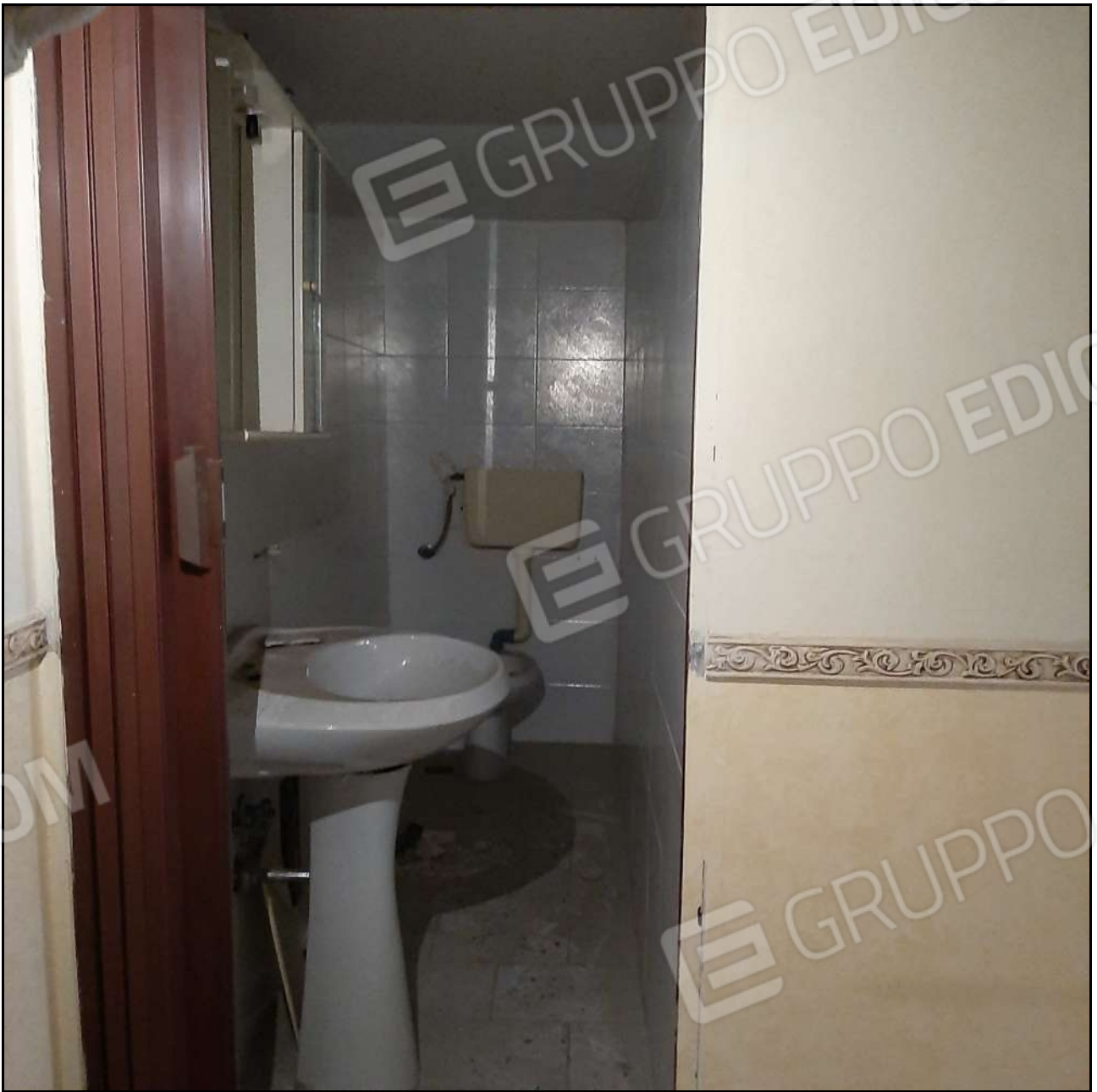
Bagno sull'area soppalcata
