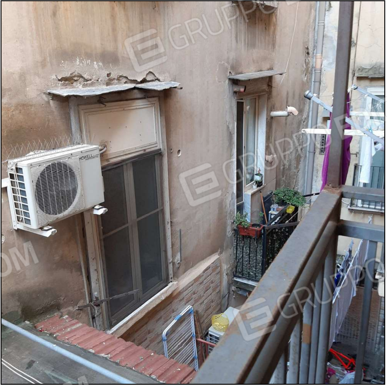
Affaccio dal balcone del bagno
