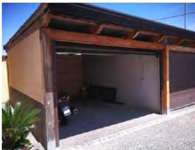
Fig. 64 – Vano box con sub 16 del box con subalterno catastale 16
