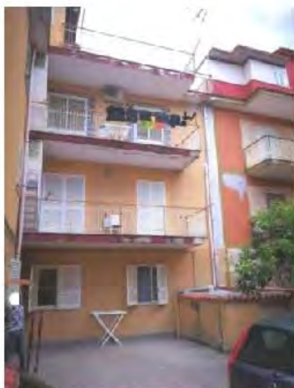
Fig. 27 – Corte pertinenziale con locale per impianti tecnici (destra) dell'appartamento al piano terra
