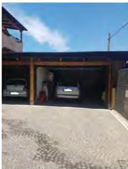
Fig. 65 – Vano box con sub 17 del box con subalterno catastale 17
