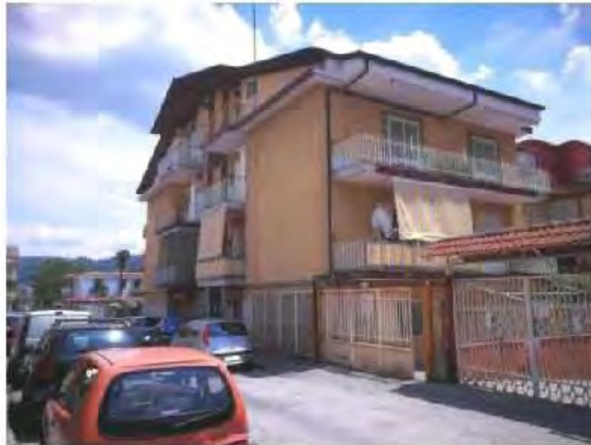
Fig. 18 – Fabbricato condominiale di via Cilea n. 6
