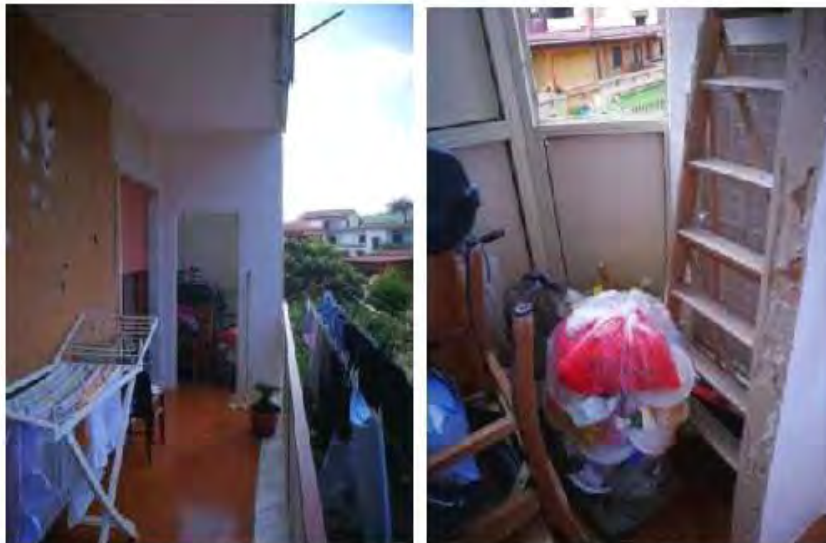
Figg. 50 e 51 – Balcone grande (foto sin.) e stiva sul balcone grande (foto des.) dell'alloggio al secondo piano
