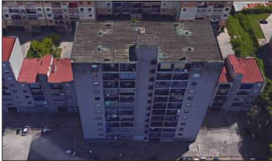
Fabbricato scala B
