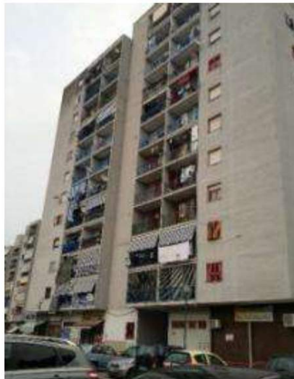
Fabbricato scala B
