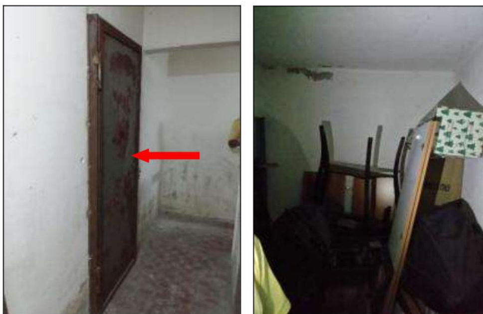
Porta d'ingresso cantina – interno cantina
