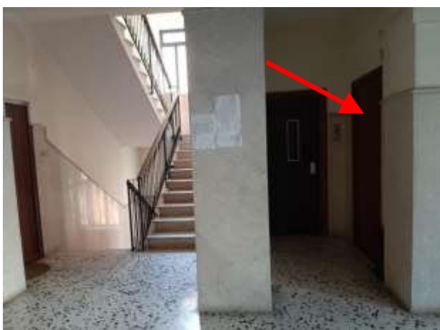
Porta d'ingresso dell'appartamento pignorato
