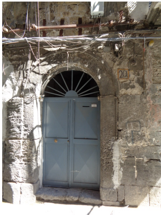
Particolare del portone d'accesso al fabbricato al civ. 20 di Via Pisanelli
