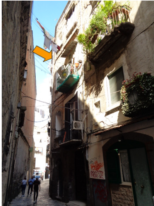
Veduta esterna del fabbricato da Via Pisanelli
