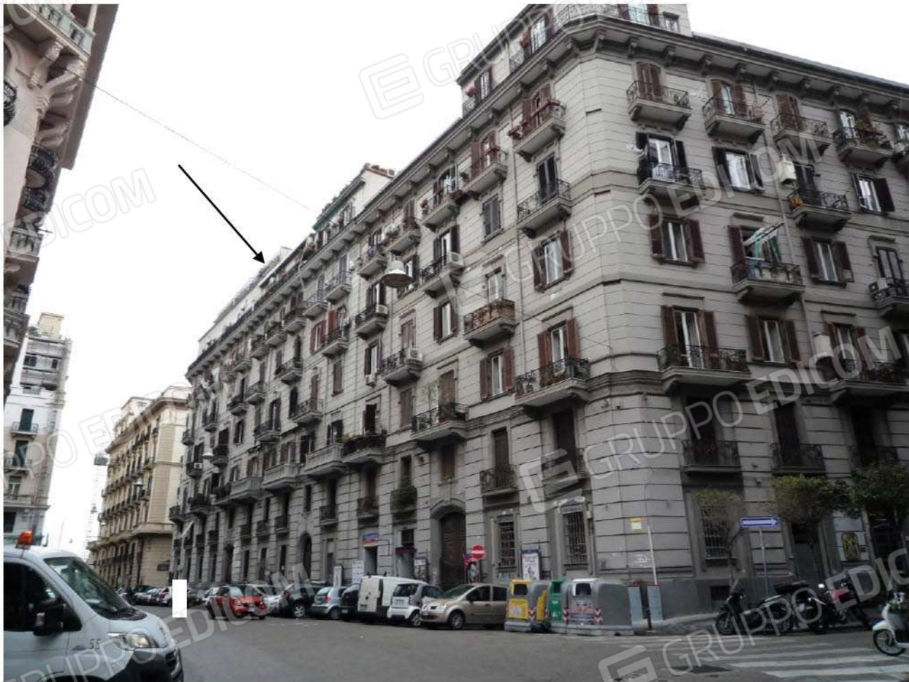
Foto n. 1: fabbricato di Via Generale Orsini, 5 di Napoli.
