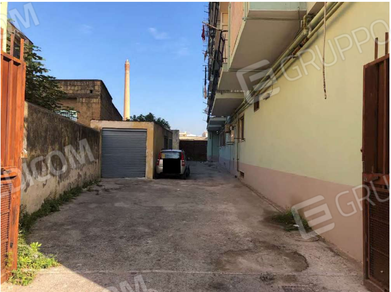
Foto 2 – Vista del viale privato con accesso dal civico 37/a
