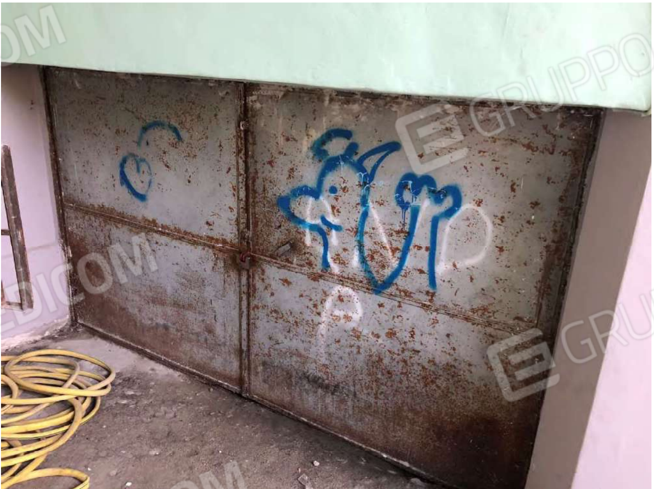
Foto 4 – Vista del varco di accesso al locale deposito in oggetto
