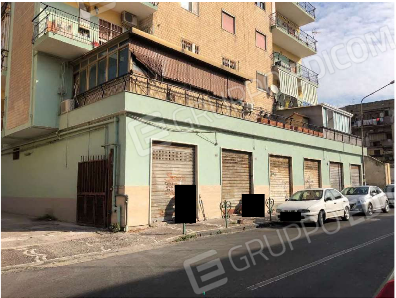
Foto 1 – Vista del fabbricato di corso Protopisani 37, Napoli
