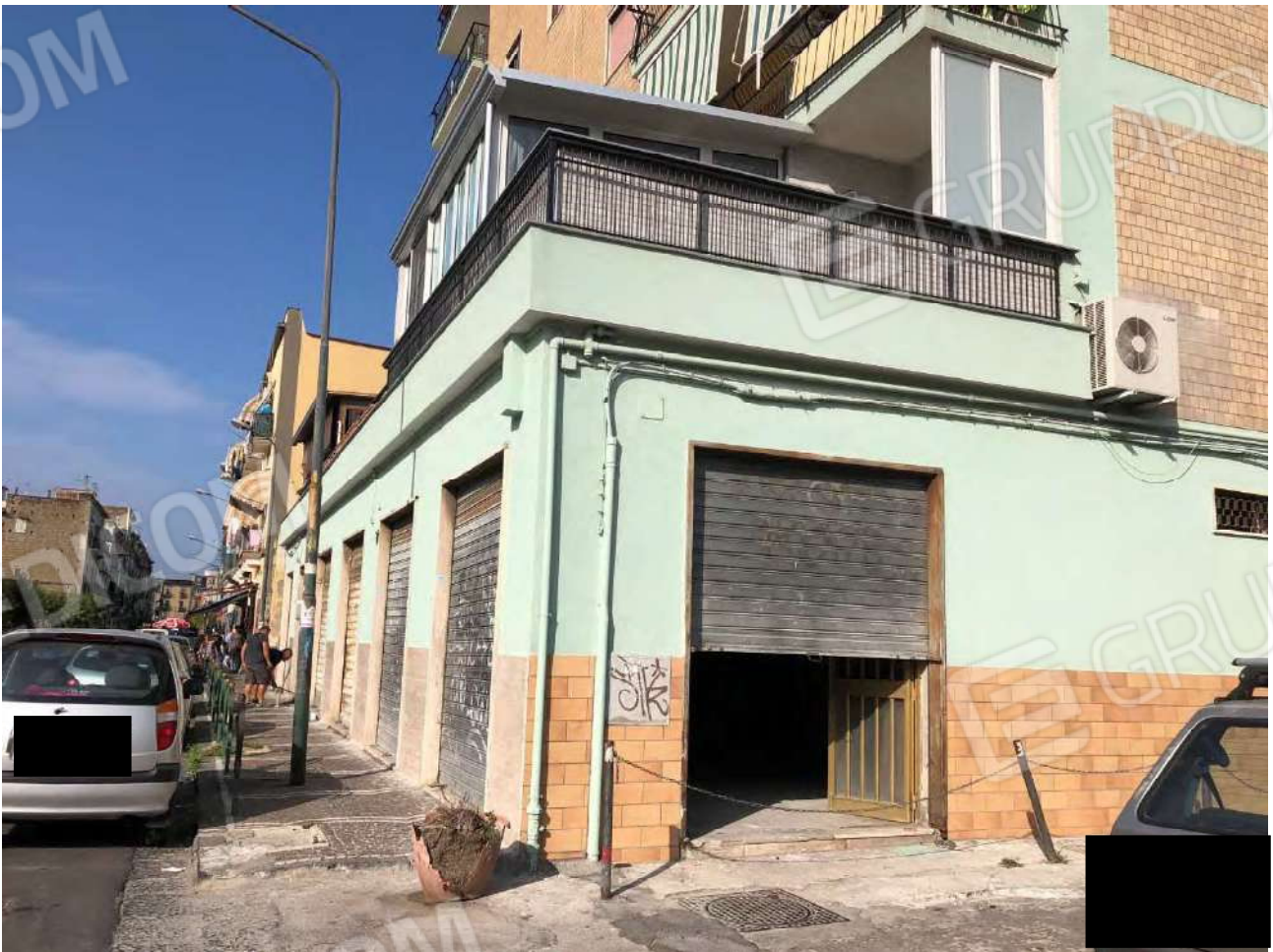
Foto 2 – Vista esterna del locale terraneo in oggetto (p.Ila 250, sub 5)
