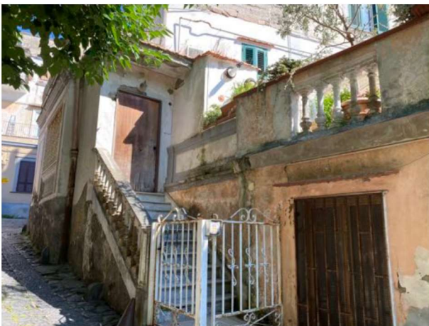
Scala di accesso
